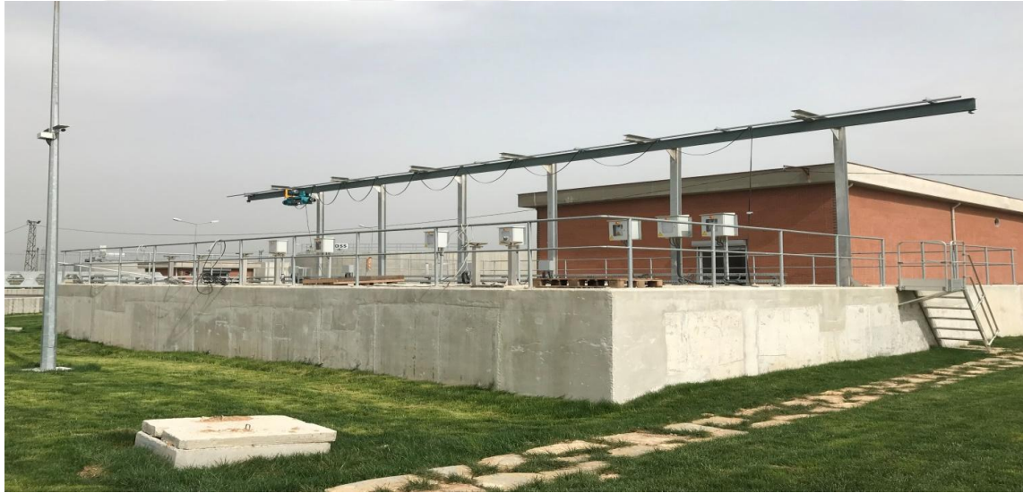
Resim 2.11. Geri devir ve fazla çamur pompa istasyonu
