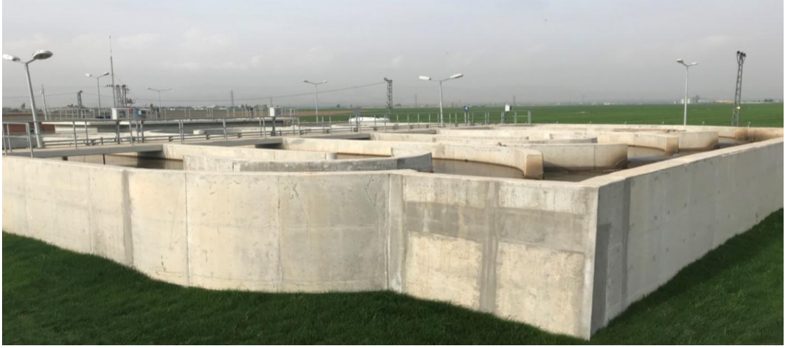
Resim 2.7. Biyofosfor havuzları
