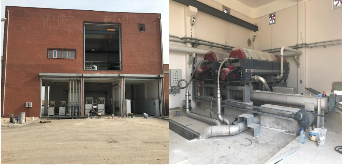
Resim 2.16. Çamur susuzlaştırma
