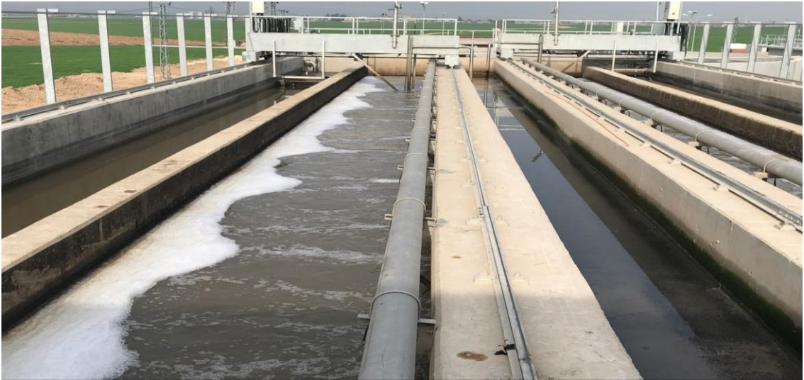
Resim 2.5. Havalandırmalı kum ve yağ tutucu
