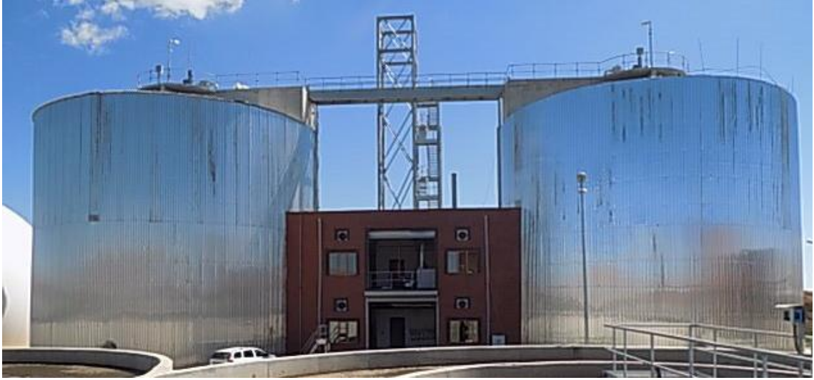
Resim 2.14. Anaerobik çamur çürütme ünitesi
