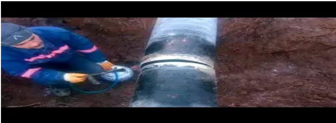
Şekil 2.4 Ön ısıtmaya tabi tutulacak kaynak bölgesinin gösterimi
