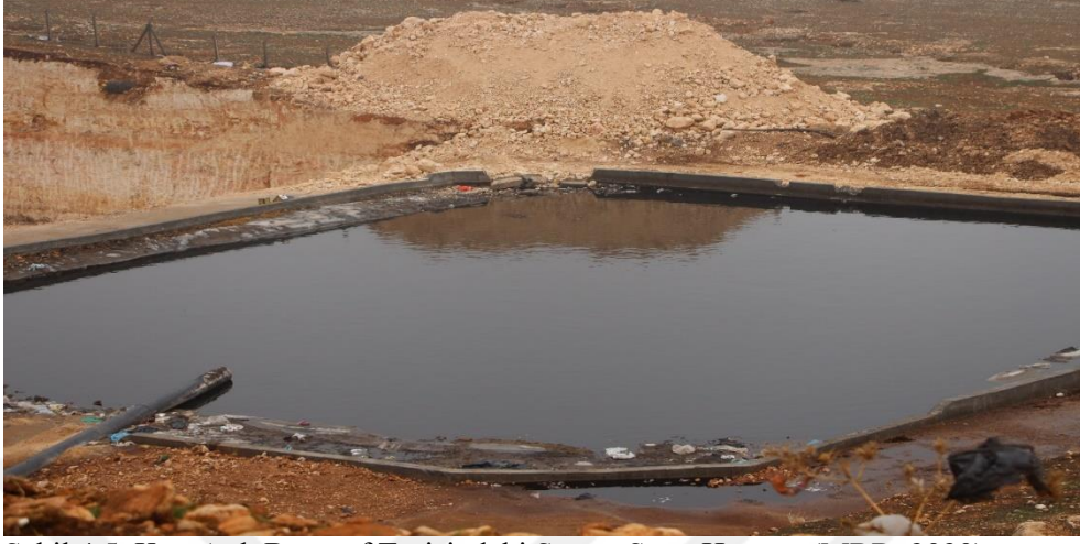
Şekil 4.5. Katı Atık Bertaraf Tesisindeki Sızıntı Suyu Havuzu (MBB, 2020).
