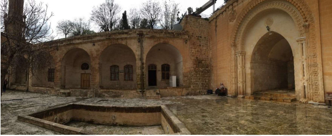
Şekil 3.13. Şehidiye Medresesi cepheleri (Kasım 2019)
