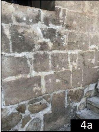
Şekil 4.22. Hatuniye Medresesinde insan etkisi sonucunda meydana gelen bozunmalar (Kasım 2019)
