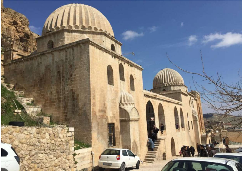
Şekil 3.7. Zincirliye Medresesi Ön Cephesi (Kasım 2019)
