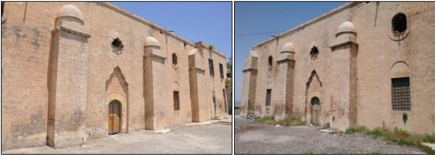
Şekil 4.30. Mor Efrem Manastırı Kilisesi Güney Cephesi
