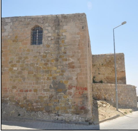
Şekil 4.9. Kuzey ve Batı Duvarı (Kaba Yonu)
