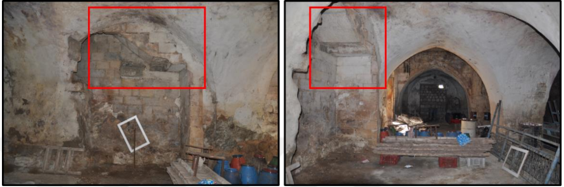
Şekil 4.60. Bodrum Kat Merdiven İzleri
