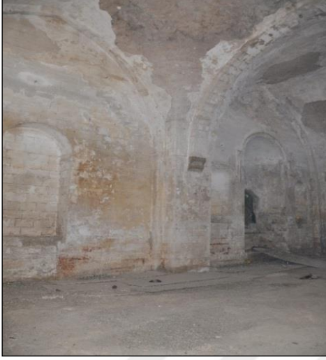
Şekil 4.32. Taşıyıcı Payandalar ve Duvarlar
