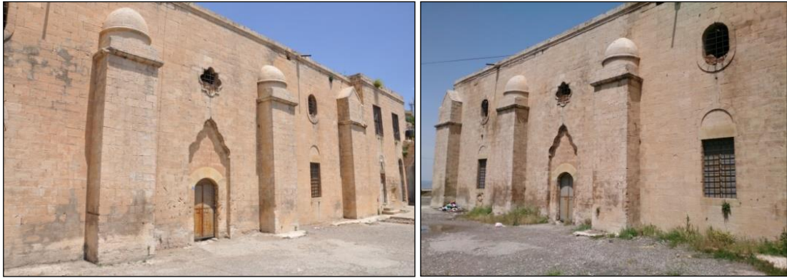
Şekil 4.35. Mor Efrem Manastırı Kilisesi Güney Cephesi
