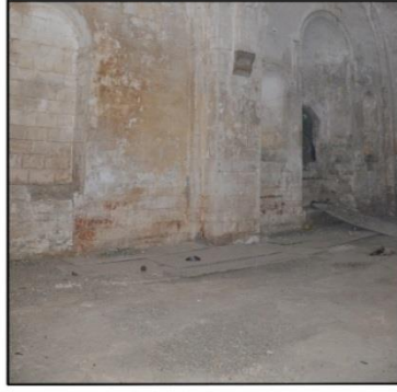
Şekil 4.54. Apsise açılan kapı Şekil 4.55. Döşemedeki beton şap Şekil 4.56. Duvardaki boya izleri
