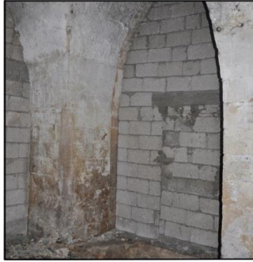
Şekil 4.53. Tuğla Duvar Örümü İle Plan Müdahalesi
