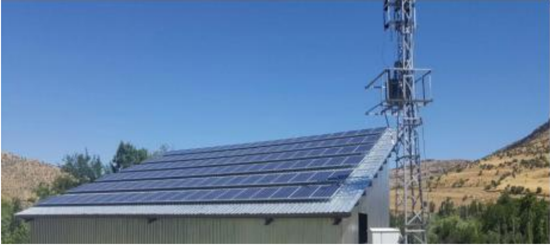
Şekil 4.3. Sürgücü Biyodisk Atıksu Arıtma Tesisi (Kaynak: MARSU)
