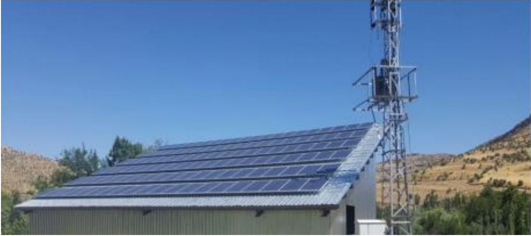
Şekil 4.3. Sürgücü Biyodisk Atıksu Arıtma Tesisi (Kaynak: MARSU)
