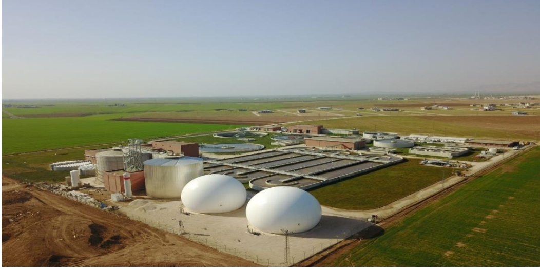
Şekil 4.2. Kızıltepe Atıksu Arıtma Tesisi (Kaynak: MARSU)
