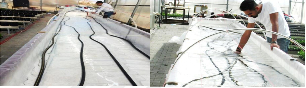
Şekil 6. Termostatl ısıtma düzeneđinin havuz içerisine yerleřtirilmesi
