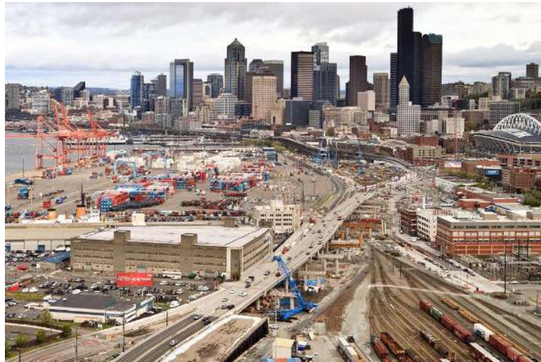
b) Alaskan Way Viaduct Replacement site
