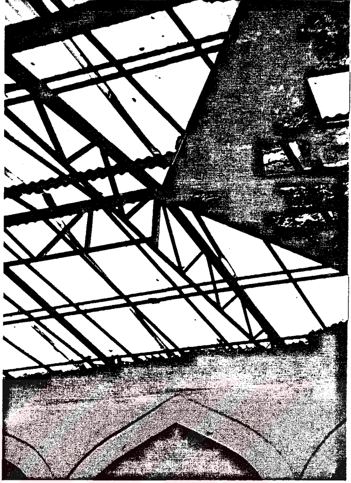
Foto: 69. Avlu Örtüsünün Çelik Konstrüksüyon Detayı.
