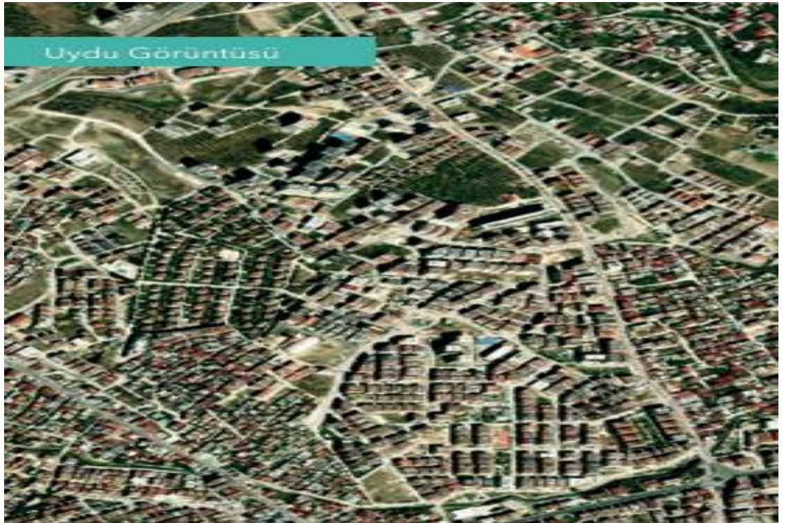
Şekil 21. Antakya 4. doku uydu görüntüsü (Akşit ve Alaydın, 2023, s. 102).
