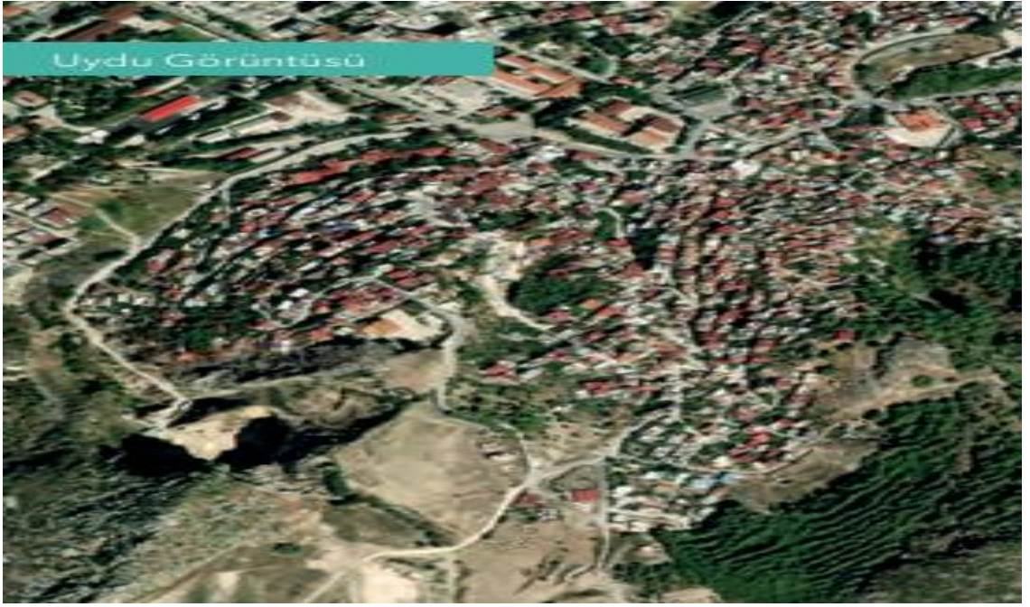
Şekil 18. Antakya 1. doku uydu görüntüsü (Akşit ve Alaydın, 2023, s. 85).
