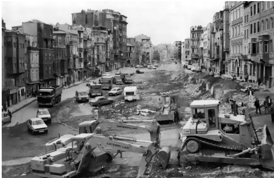
Figure 3. 7. After demolition, before asphaltting ( http://www.arkaplanlar.com/resimler-il-il-turkiye-resimleri-79-eski-istanbul-630-tarlabasi-bulvari-acilirken-11936.html ).
