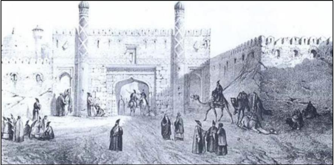
Şekil 4.78. 1780'de yıkıcı depremten sonra yeniden inşa edilen Tebriz tahkimatı (Zoka, 1980, s. 88)
