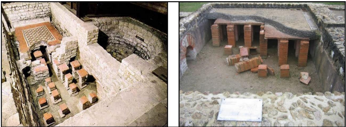
Görsel 2.2. Hypocaust ısıtma sistemi (http-16, 2020)
