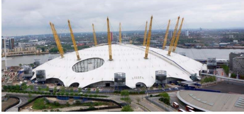
Şekil 15 : O2 Arena (PTFE) Teflon Çatı Kaplaması
