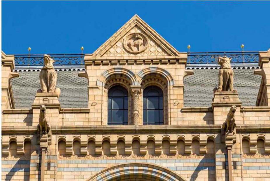
Şekil 8 : Tuğla ve Taş Malzemenin Yapıda Kullanımı
