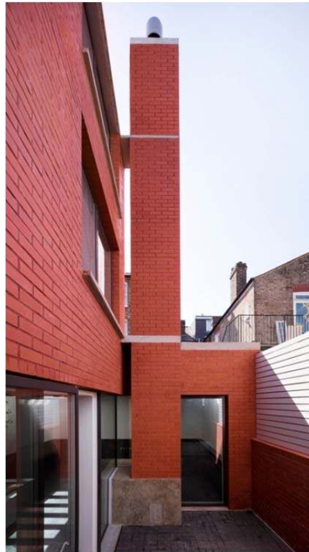
Şekil 7 : Tuğla Malzemenin Cephede Kullanımı (Red House/Londra)
