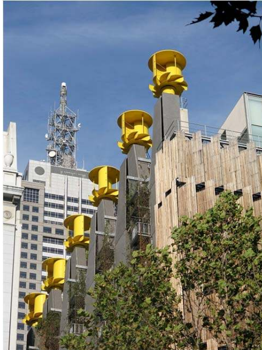
Şekil 68: CH2 (Avusturalya Belediye Meclisi Binası) Rüzgar Türbinleri
