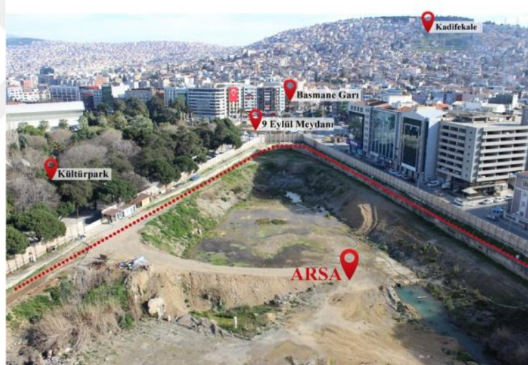
Şekil 5.2 Arsanın mevcut durumu (Kişisel arşiv, 2018)
