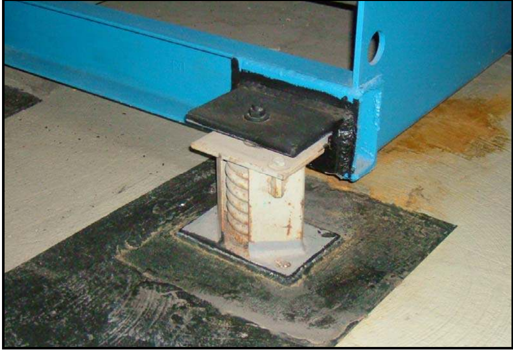
Şekil 3.65. Betona gömülü çelik plakaya kaynatılmış sismik izolatör
