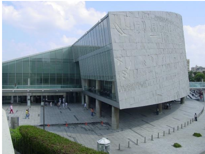
Şekil 3.59. İskenderiye Kütüphanesi bina giriş bölümü ve granit yüzey (Langdon, 2015)
