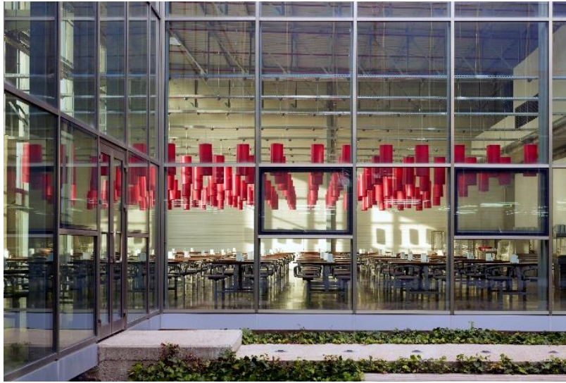
Şekil 3.76. İpekyol Tekstil Fabrikası iç bahçe ve yemekhane doğal ışık kullanımı (Kara, 2010)
