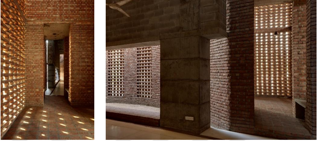
Şekil 3.94. Bait Ur Rouf Cami hava akışı sağlayan boşluklu tuğla kullanımı (Vora, 2025)
