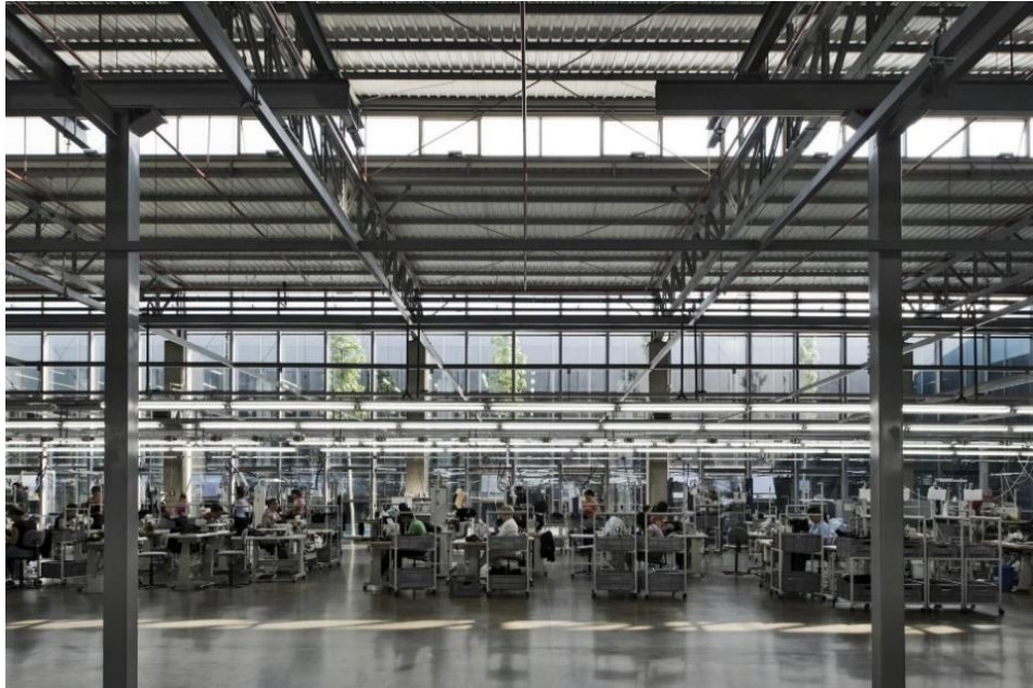
Şekil 3.80. İpekyol Tekstil Fabrikası üretim alanı doğal ışık kullanımı (Anonim, 2025)
