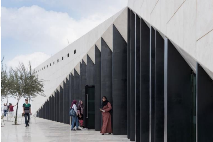
Şekil 3.99. Filistin Müzesi batı cephesi dış cephe (Anonim, 2025)
