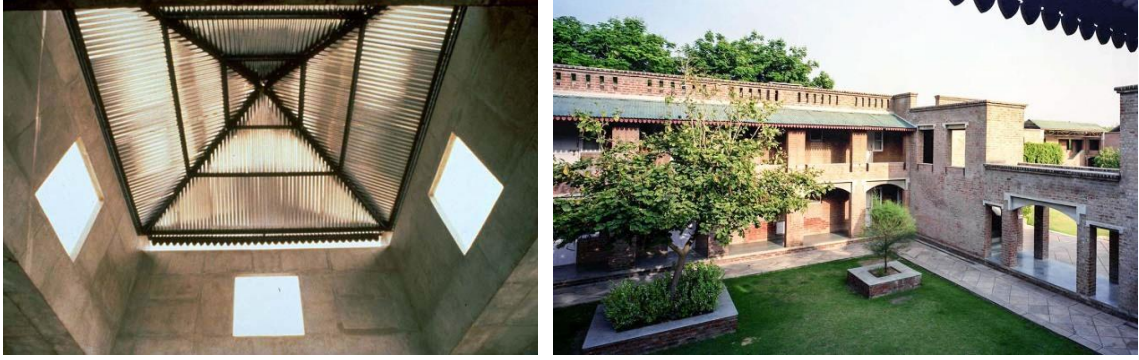
Şekil 3.37. EDII tüm kampüsü kaplayan çelik makas çatı (Bahga, 2019)
