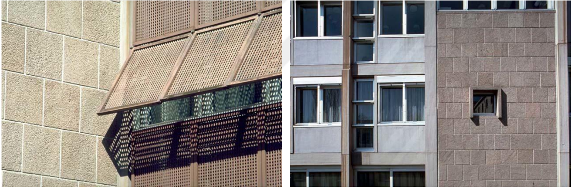
Şekil 3.2. TTK binası ahşap paneller, alüminyum pencere ve taş kaplama dış cephe (AKTC, 2025)
