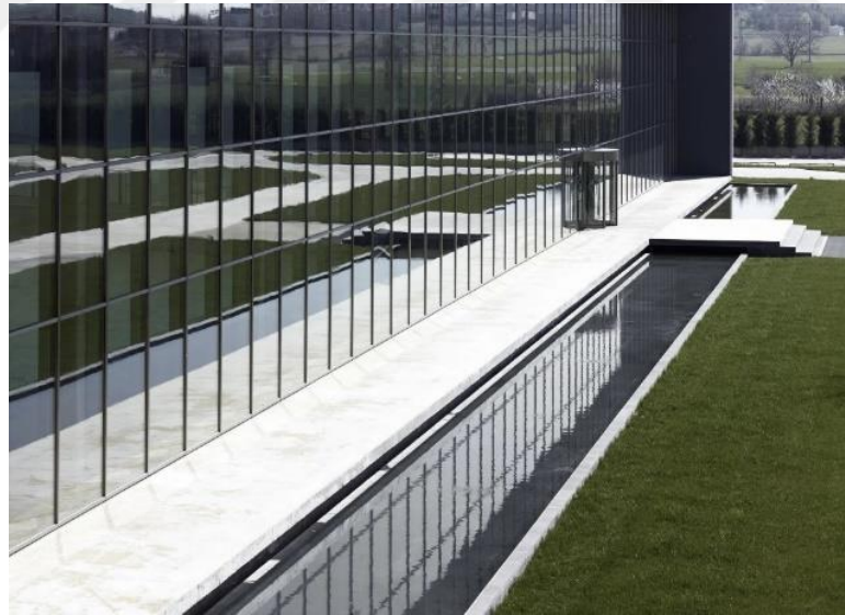
Şekil 3.78. İpekyol Tekstil Fabrikası ön cephe havuz (Anonim, 2025)
