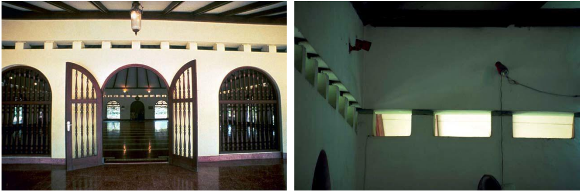
Şekil 3.22. Said Naum Cami ahşap kafesli pencereler ve üzerinde yer alan şerit açıklıklar (AKAA, 2025e)
