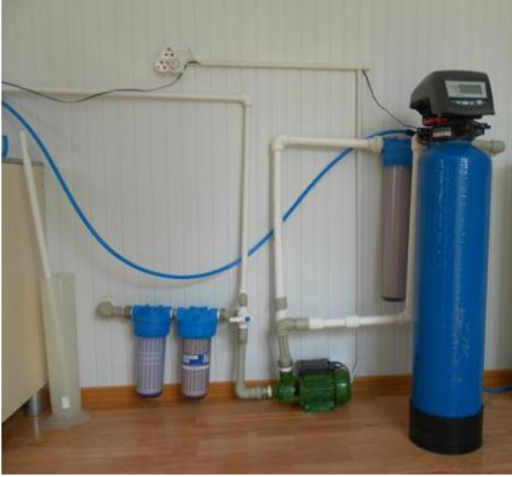
Şekil 3. 14 Yıkanabilir kartuş filtreler, kum filtre ve 10 mikronluk kartuş filtre
