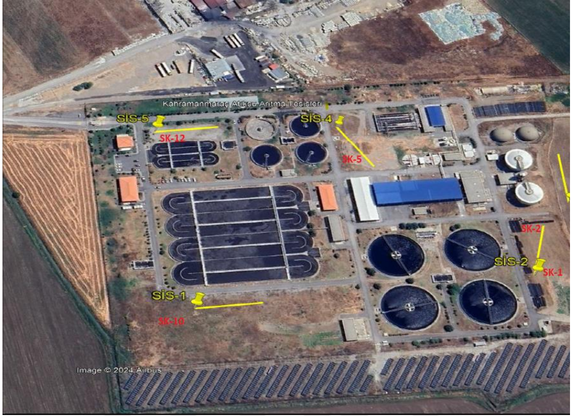
Şekil 4.2. Proje alanı üzerindeki sondaj ve sismik ölçüm yerleri
