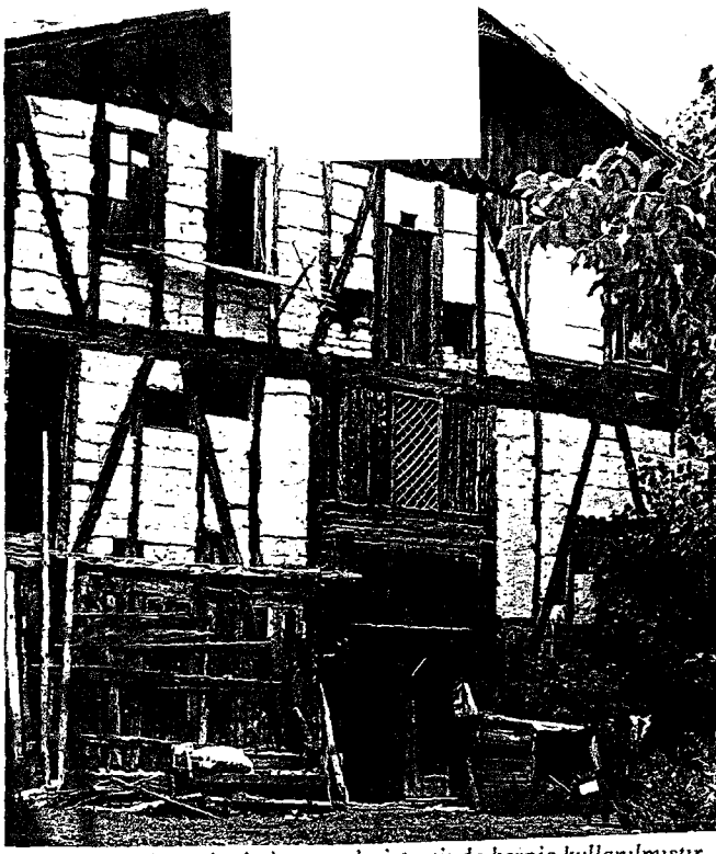
Fotoğraf 23. Pazarköy' Bucak merkezinde çarmık sisteminde kerpiç kullanılmıştır
