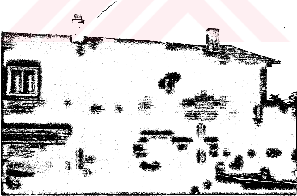
Fotoğraf 20. Akçakoca köyünde çatki tarzında yapılmış bir mesken. Çatki tarzında düzgün çam veya köknar tomrukları yanlardan çentiklenerek üst üste yığılır. Meskenin özellikle siyat kısmı bu tarzda inşaa edilir.
