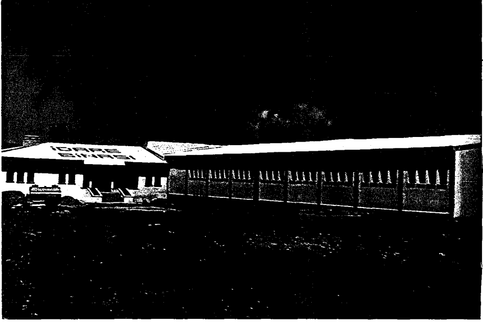
Fotoğraf 34. Mengen'de Karton ve ambalaj Fabrikasının yapılmakta olan binası görülmektedir
