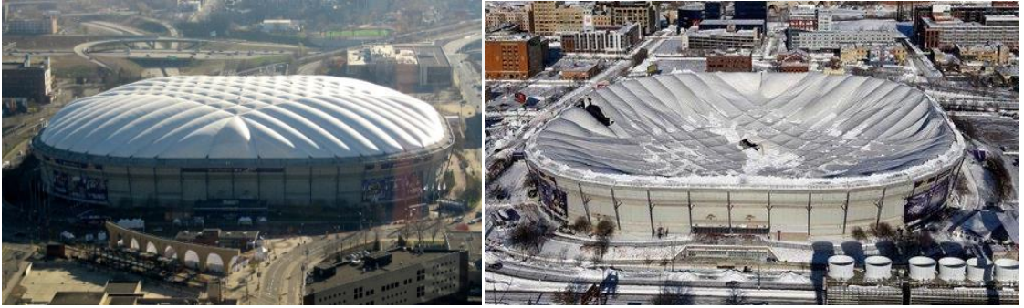
Şekil 2.5. Kar ve buzun ağırlığından kaynaklanan Metrodome çatısının çökmesi
