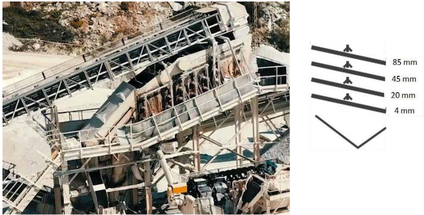
Şekil 3.10 Kırma eleme tesisinde bulunan elek ve eleme katları (Gürsan).
