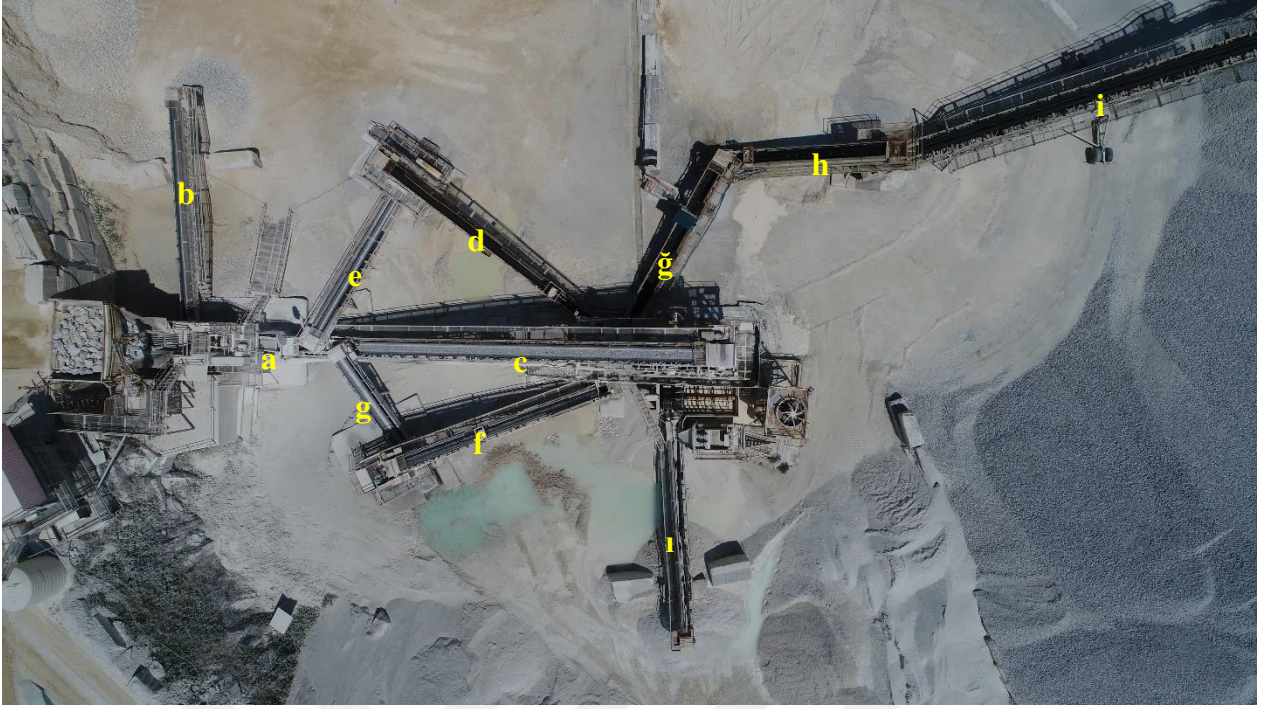
Şekil 3.11 Tesiste bulunan bant konveyörler.
