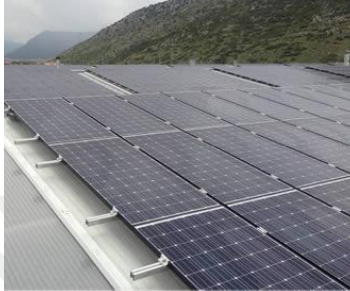
Şekil 4.14 Portsan Mermer Çatı GES uygulaması.
