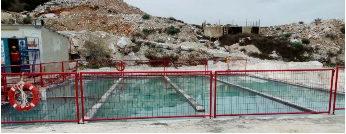
Şekil 4.17 Kırma eleme tesisinde kullanılan çökeltme havuzu.
