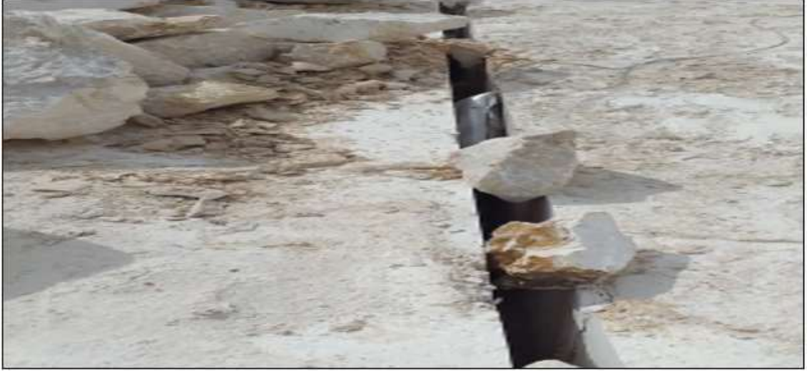
Şekil 19. Saç balonunun şişirilmesi ve açılan alana taş atılması
