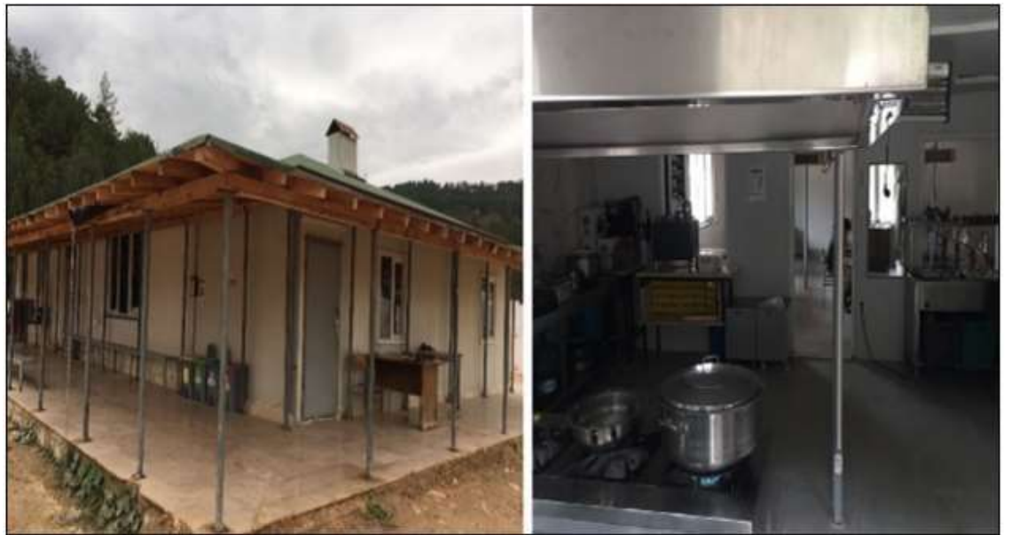
Şekil 33. Yemekhanenin dıştan ve içten görünüşü
