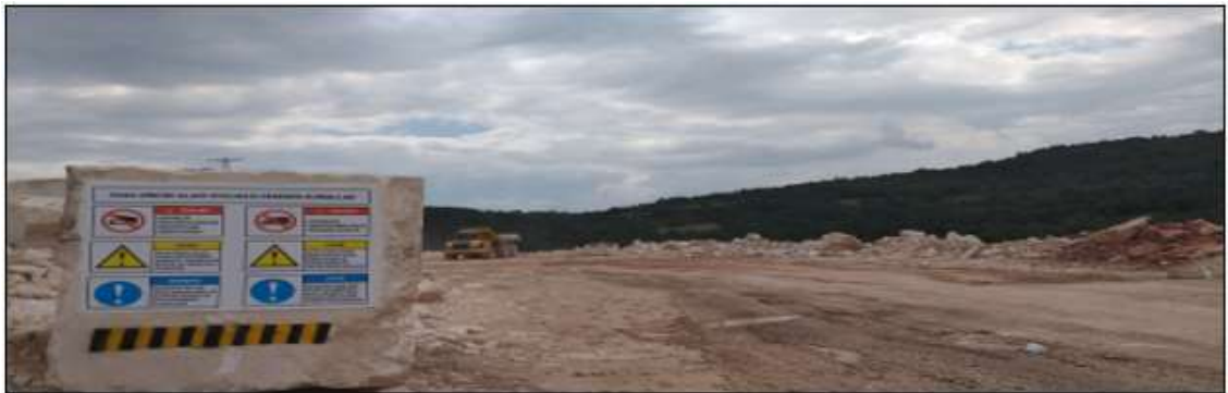
Şekil 29. Pasa döküm sahası
