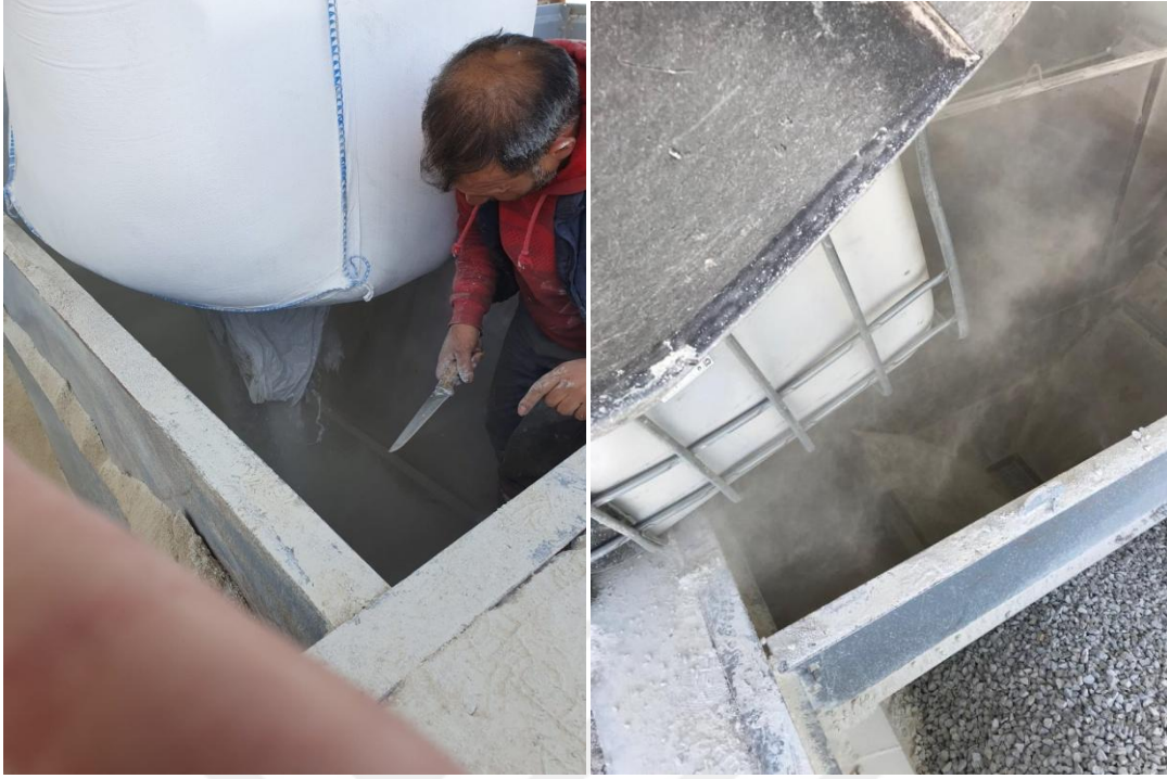
Şekil 3. 2 Uçucu kül ve mermer tozunun bunkerlere alınması.
