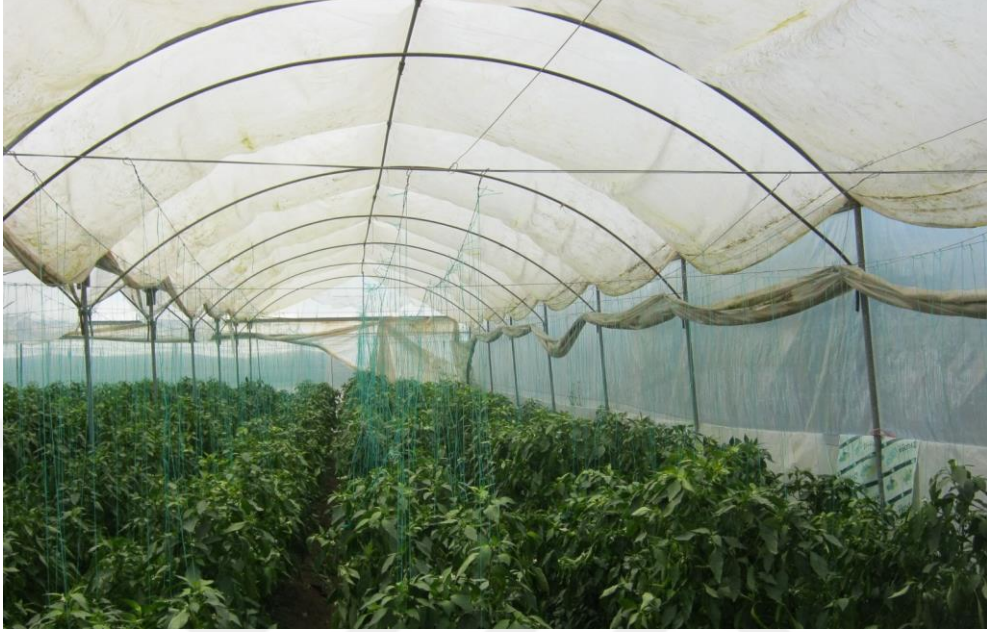
Fotoğraf 4.3. Adanalioğlu atısı Yay Boru Sistemli Sera
