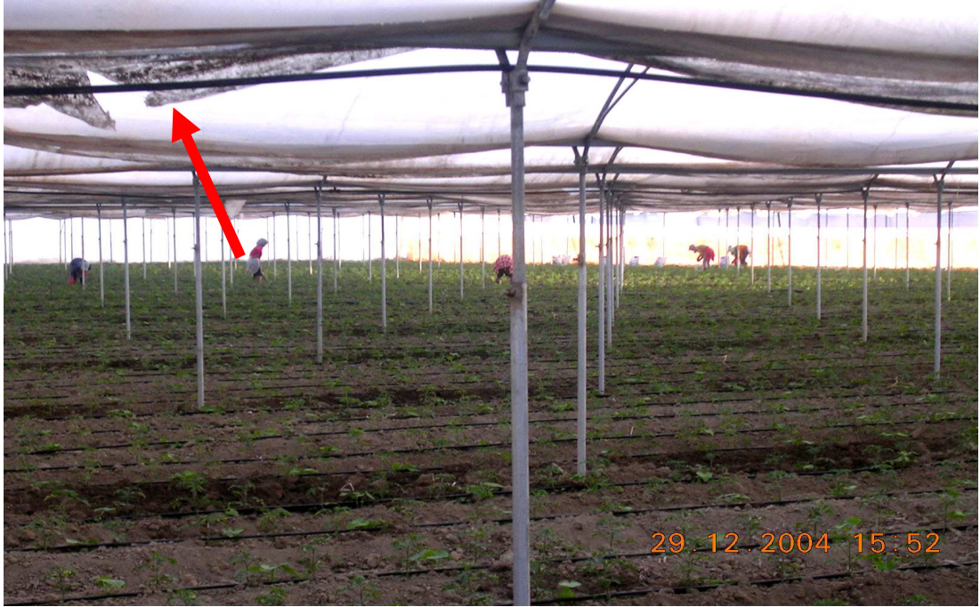
Resim 4.18. Plastik Serada Örtü Malzemesinde Oluşan Deformasyon (Kazanlı, 2004)
