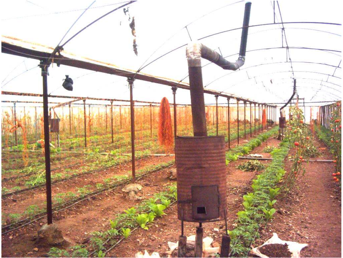
Resim 4.16. Plastik Serada Sobalı Isıtma Sistemi (Kazanlı, 2003)
