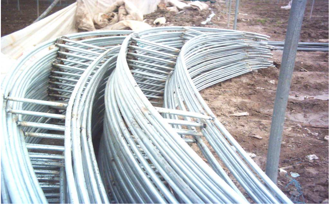
Resim 4.6. Yay Çatılı Borulu Sistem Serada Çatı Malzemelerinin Kaynakla Birleştirilmesi (Adanalıoğlu, 2003)
