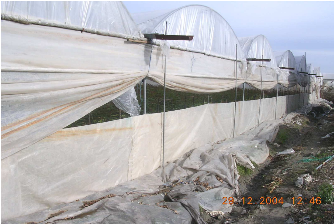
Resim 4.13. Plastik Seralarda Doğal Havalandırma (Tarsus, 2004)
