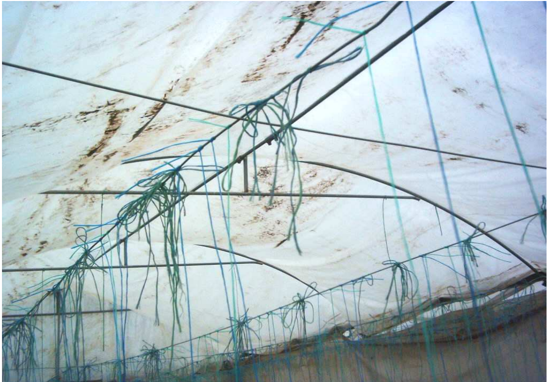
Resim 4.19. Sera Örtü Malzemesinde Oluşan Kirlilik (Tarsus, 2003)
