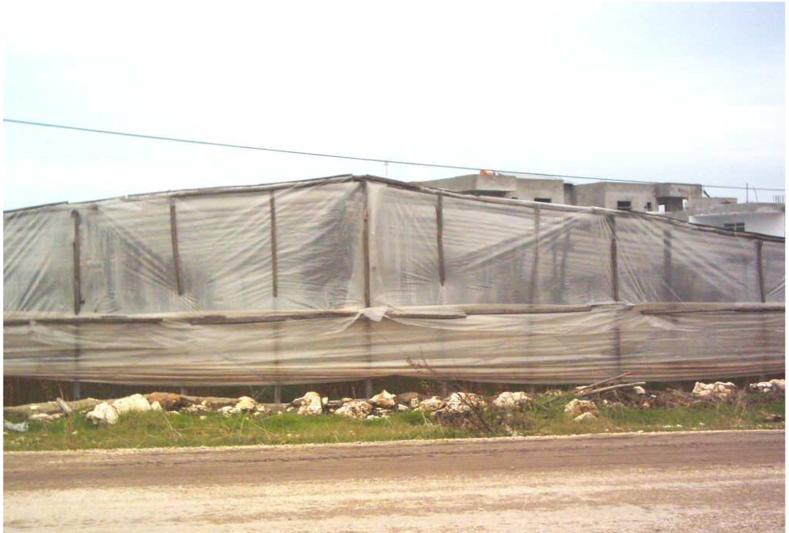
Resim 4.4. Beşik Çatılı Ahşap Malzemenin Kullanıldığı Sera Sistemi Dış Görünüşü (Erdemli, 2003)
