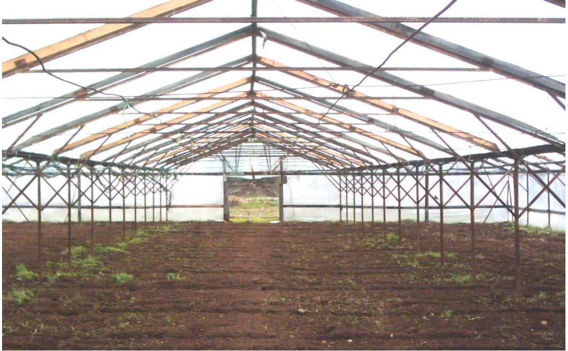
Resim 4.3. Beşik Çatılı Ahşap+Çelik Malzemenin Beraber Kullanıldığı Sera Sistemi İç Görünüşü (Erdemli, 2003)
