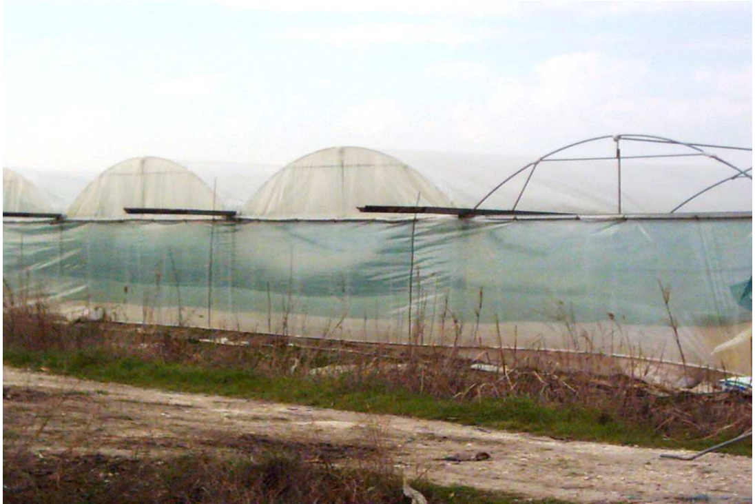
Resim 4.5. Yay Çatılı Çelik Borulu Malzemenin Kullanıldığı Sera Sistemi Dış Görünüşü (Erdemli, 2003)
