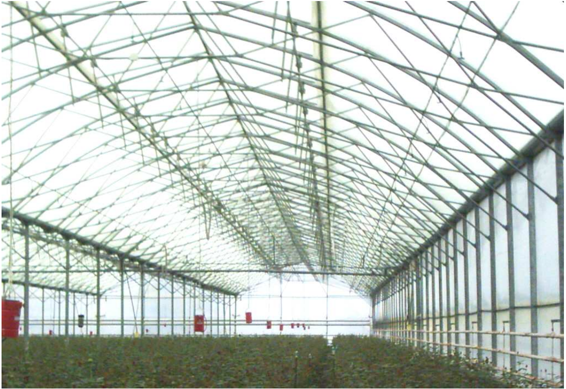
Resim 4.2. Beşik Çatılı Profil Sistem Gül Serasının İç Görünüşü (Çiçekli, 2003)
