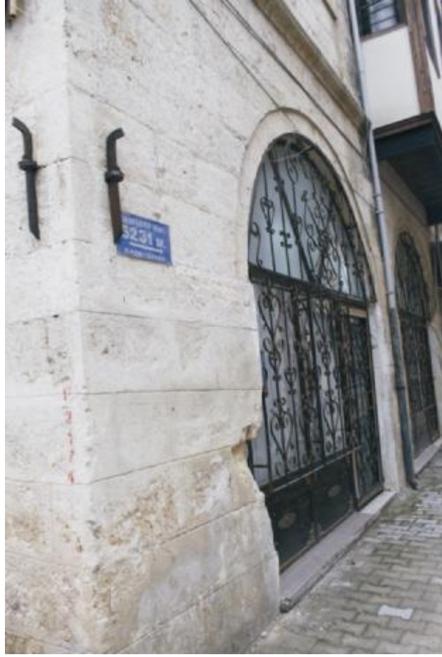
Resim.4.17. Kemerli Dükkân Cephesi Görünümü.
