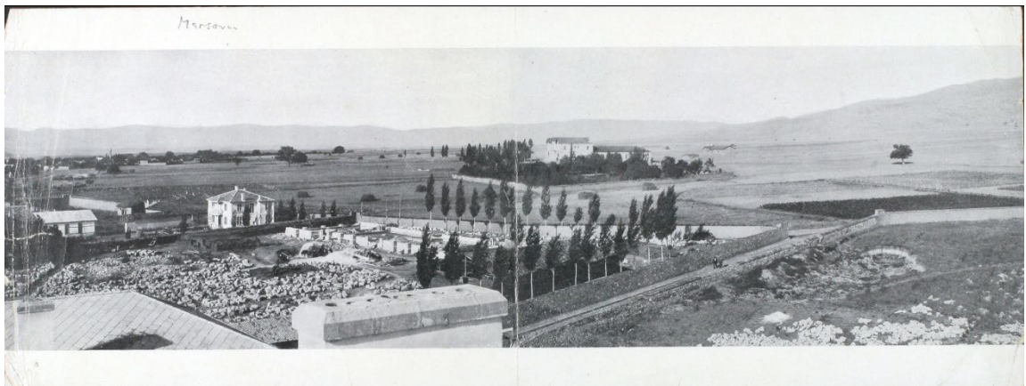
Şekil 3.17. Birlik Binası temeli (http-33)
