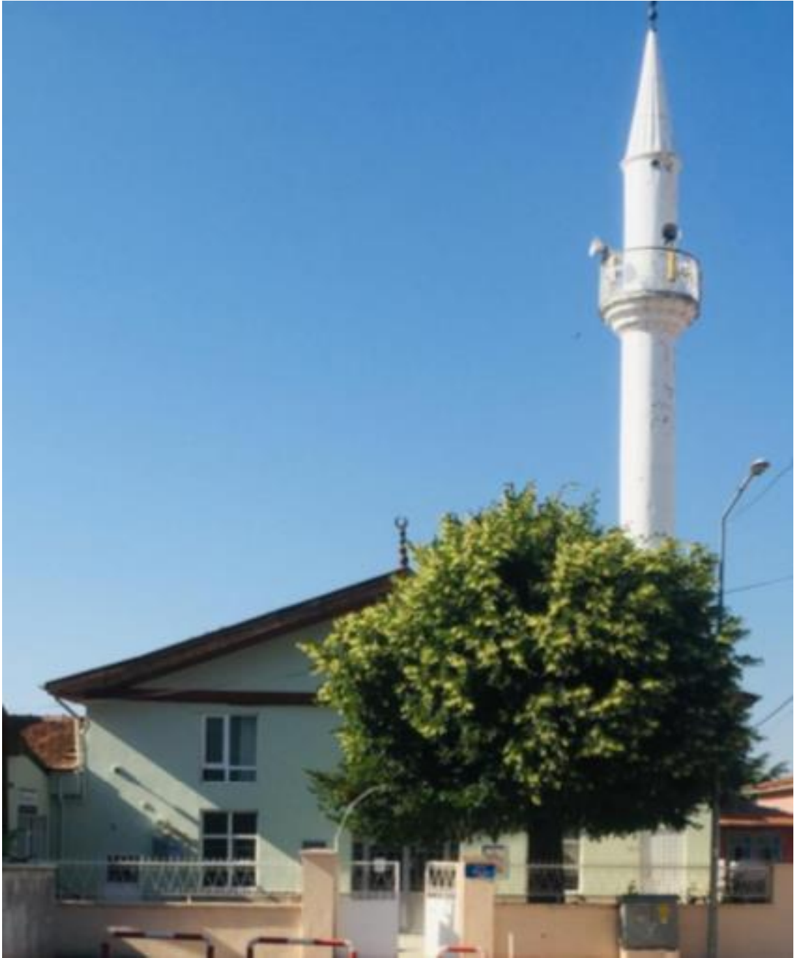
Resim 7. Büyük Hacı Hasan Cami Kuzey Cephe Görünümü
