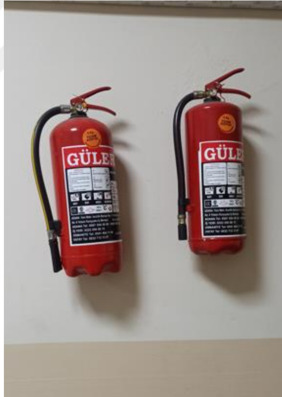
Şekil 4.13. Yeterli Sayıda ve Uygun Yükseklikte Yangın Tüpü
