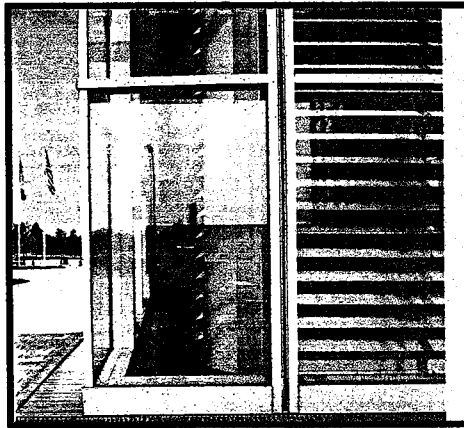
RESİM 6.16 Occidental Chemical Centre Binası'nın Giydirme Cephe Görünüşü, (Wigginton, 1996, p.160).
