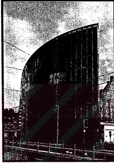
RESİM 6.18 The Business Promotion Centre And The Technology Centre" Binası'nın Dış Görünüşü, (Detail 1993-3 p.297).
