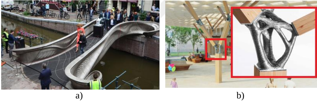
Şekil 2.9 Eİ ile üretilmiş a) köprü ve b) yapı bağlantı elemanı (MX3D, 2022)
