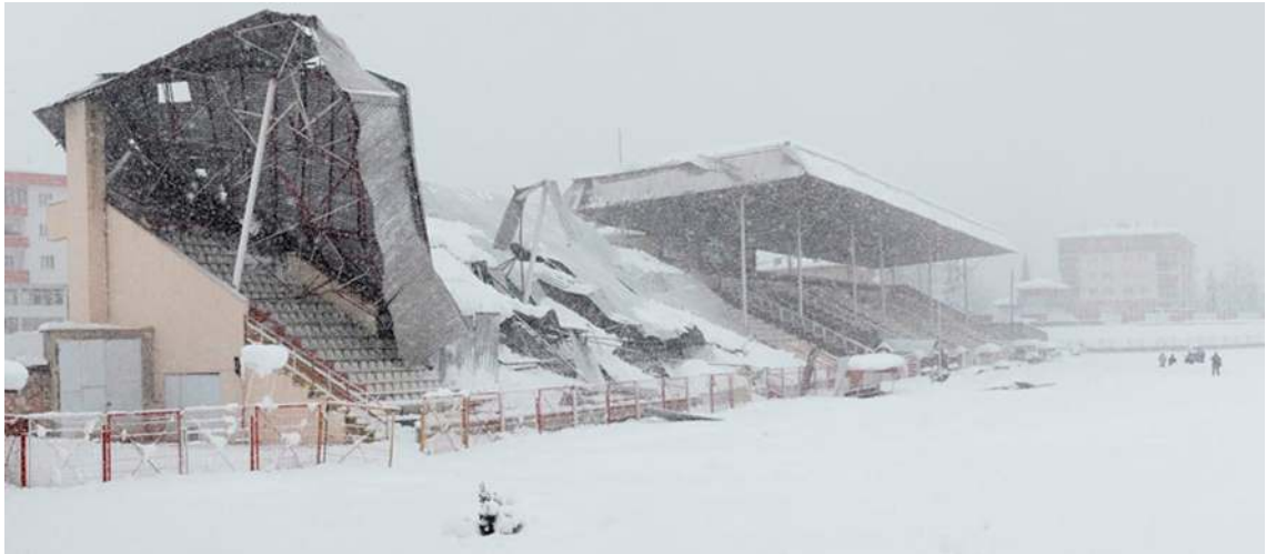
Şekil 1.1. Bilecik Edebalı Stadı çatısının çökmesi(URL-1).
