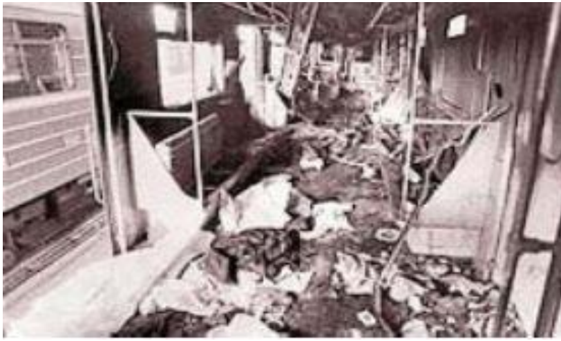
Şekil 4.31: Bakü metrosu yangın sonrası vagonun iç görünümü 1
