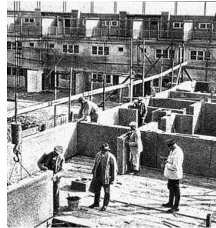
Şekil 2.7 Praunheim Şantiyesi, E. May, Frankfurt.
