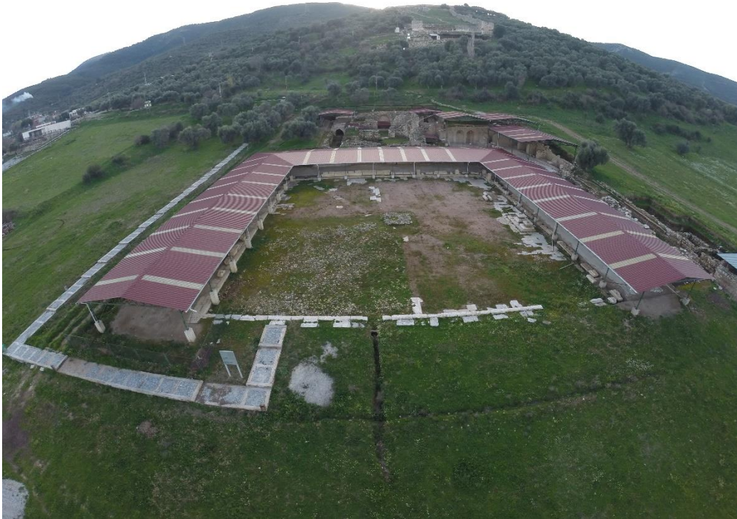
Resim 2: Metropolis Aşağı Hamam-Palaestra Yapısı
