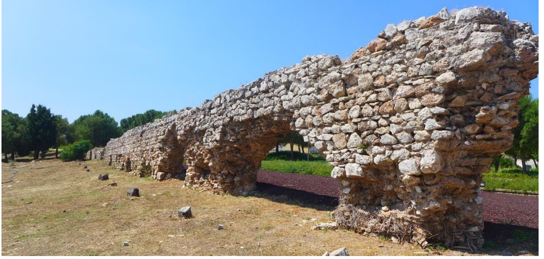
Şekil 13: L. Arkas Arazisinde Kalan Su Kemerı Kalıntısı
