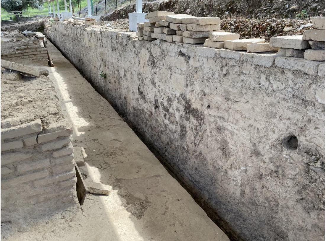
Şekil 89: Batı Servis Koridoru Duvarında Bulunan Barbakan Delikleri
