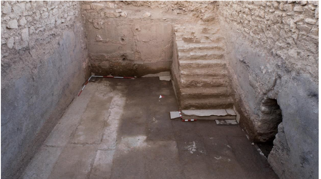
Şekil 67: Sarnıç İçinde Bulunan Merdiven ve Mermer Kaplama İzleri
