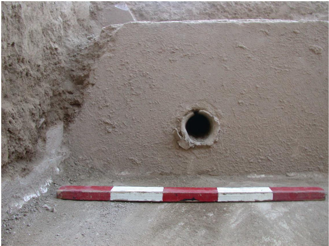
Şekil 34: Aşağı Hamam'da Kullanılan Kurşun Boru Örneği
