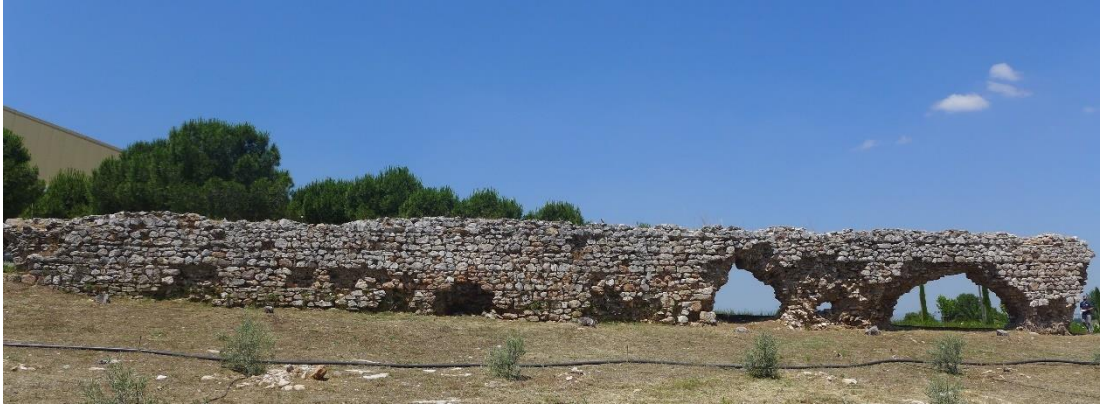
Şekil 14: L. Arkas Arazisinde Kalan Su Kemerı Kalıntısı
