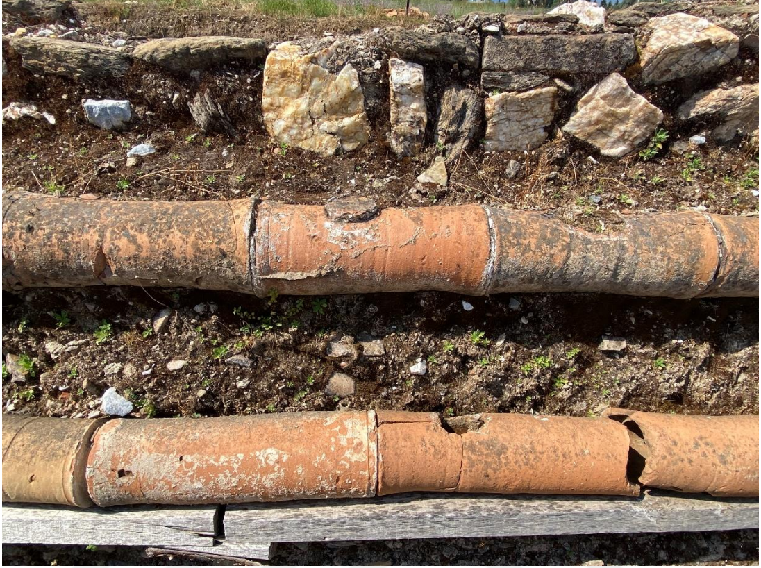
Şekil 37: Künklere Açılan Kontrol Delikleri
