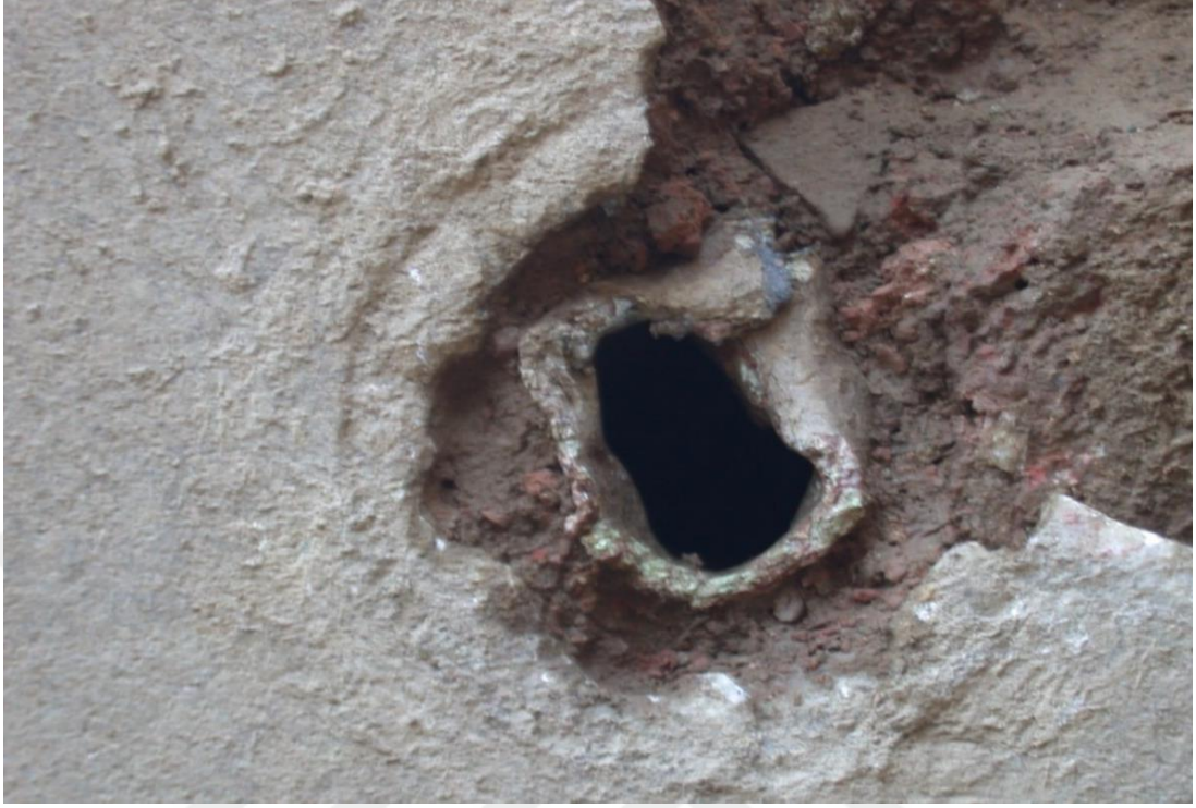
Şekil 34: Aşağı Hamam'da Kullanılan Kurşun Boru Örneği
