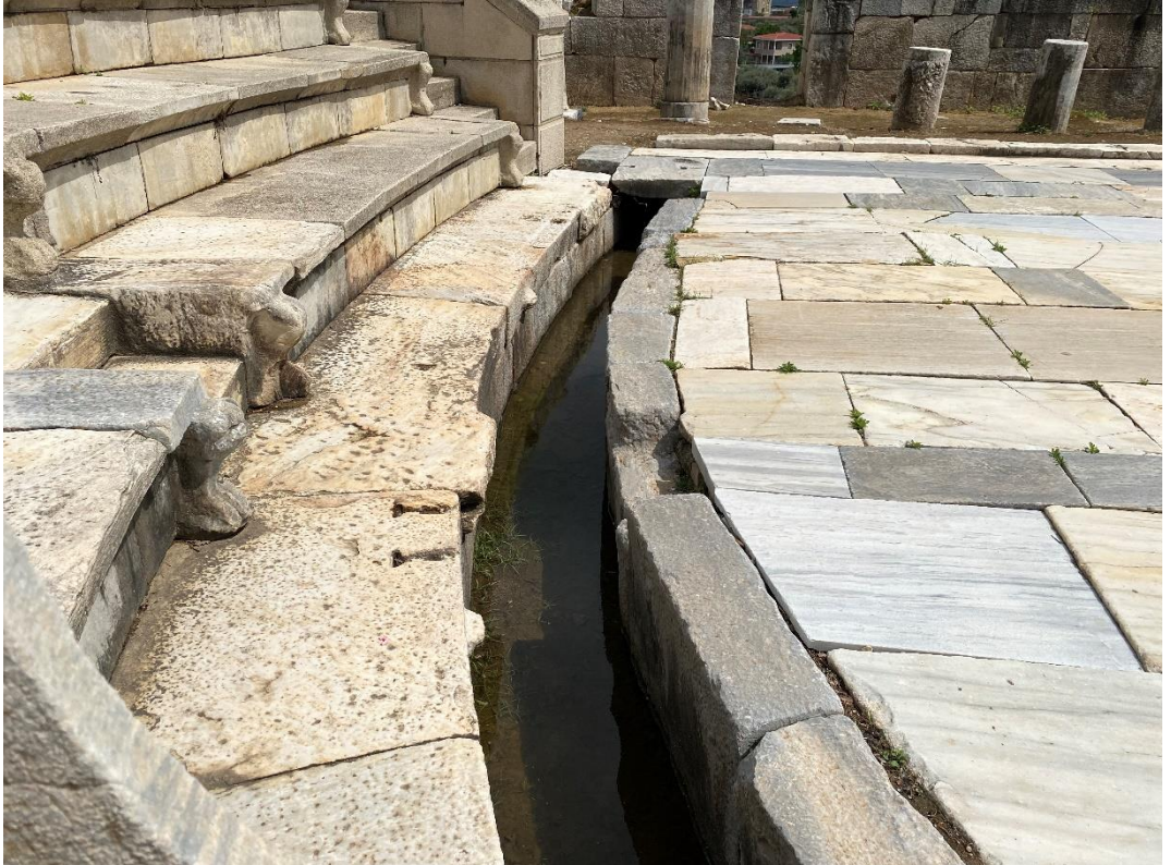
Şekil 83: Tiyatro Orkestrası Tahliye Kanalı
