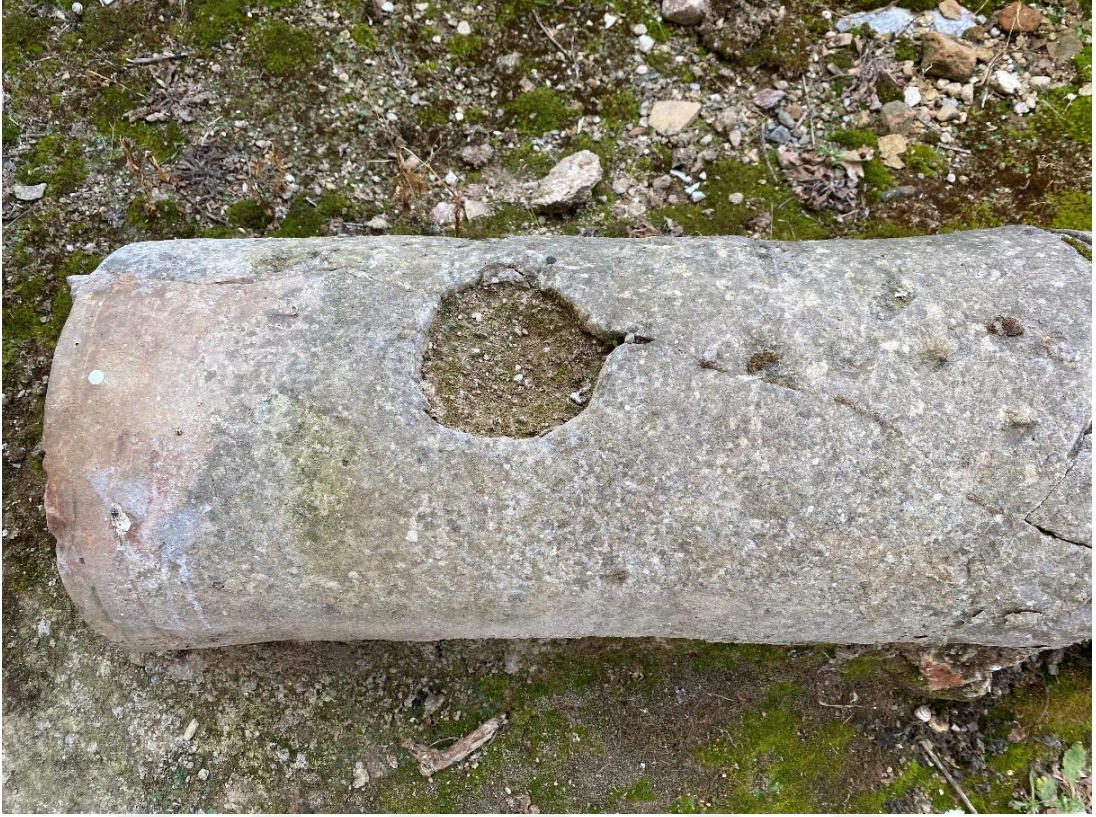
Şekil 38: Künklere Açılan Kontrol Delikleri
