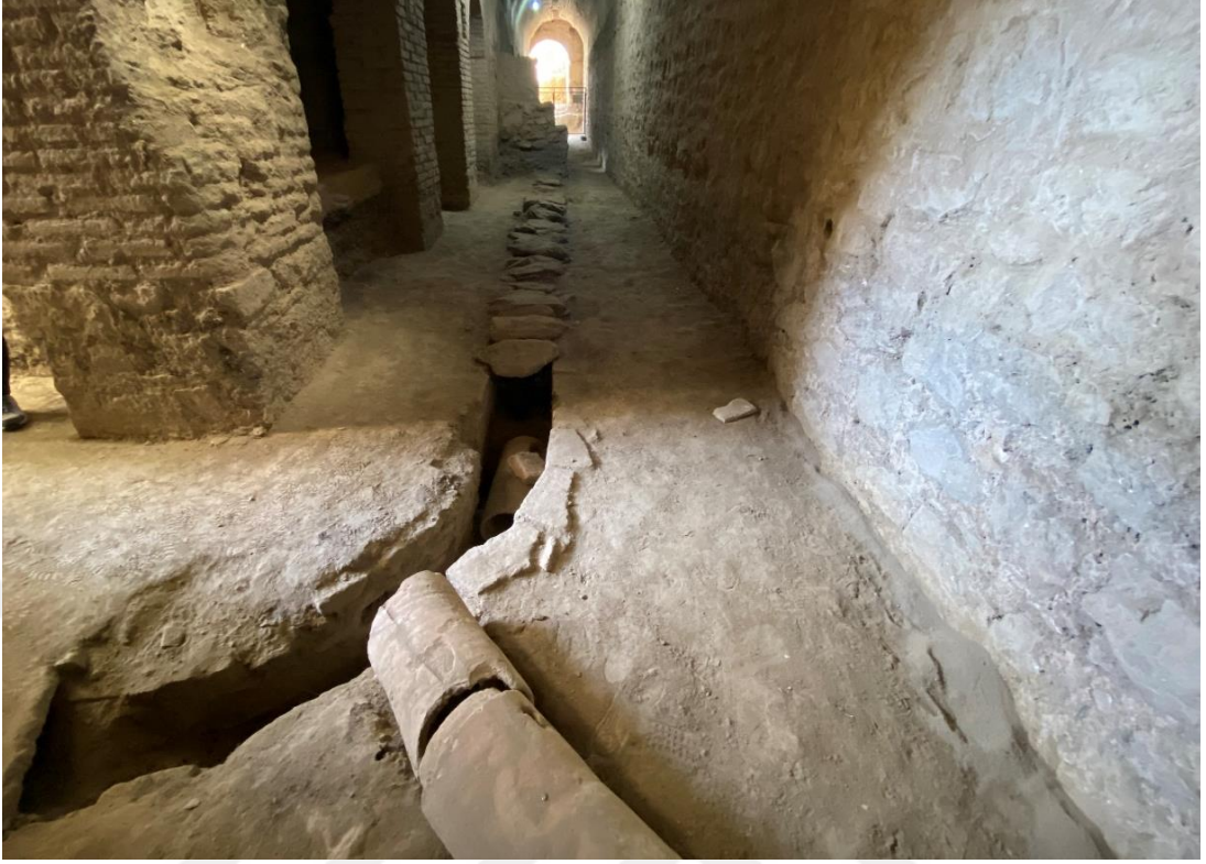
Şekil 87: Güney Servis Koridoru Tahliye Kanalı
