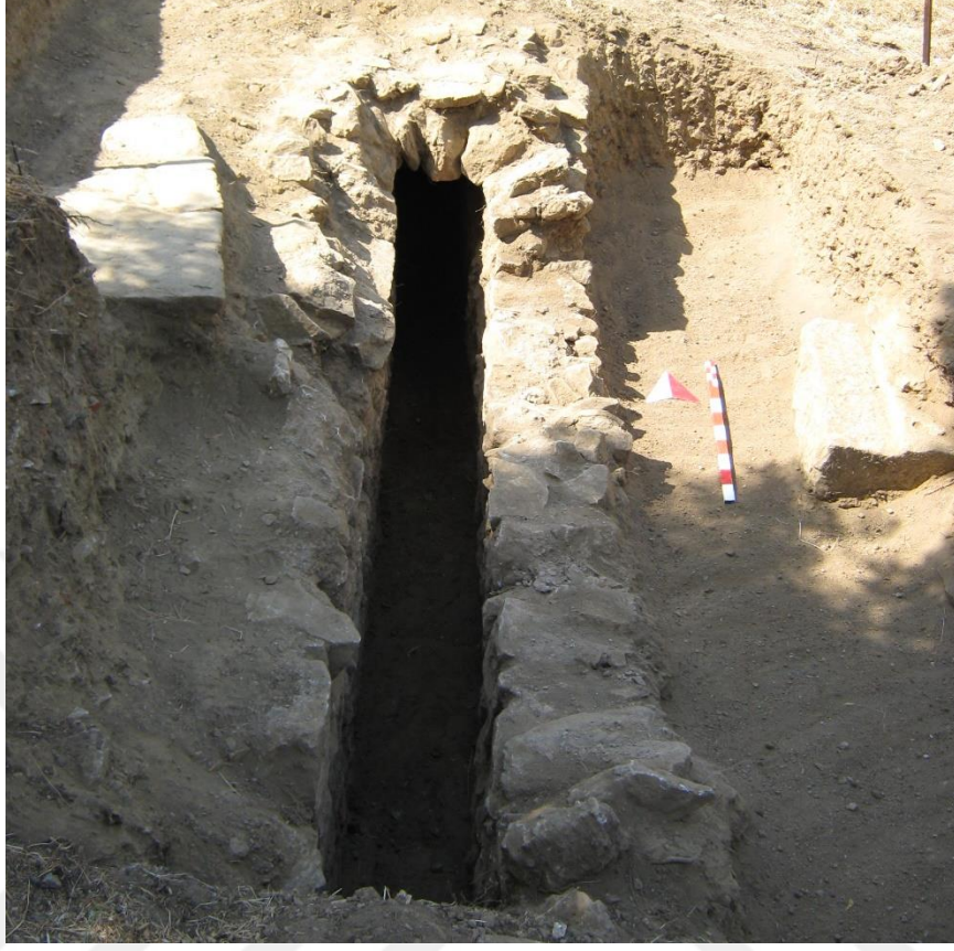
Şekil 81: Ana Kanalizasyona Bağlantı Yapan Yan Hat Örneği
