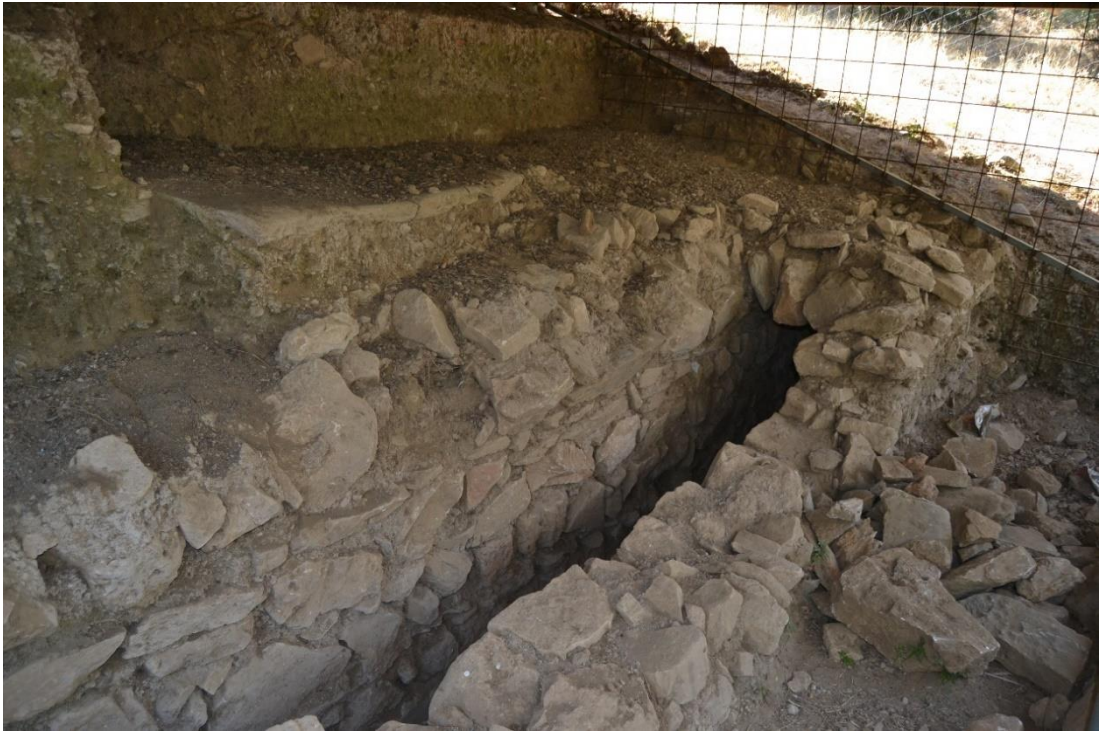
Şekil 81: Ana Kanalizasyona Bağlantı Yapan Yan Hat Örneği
