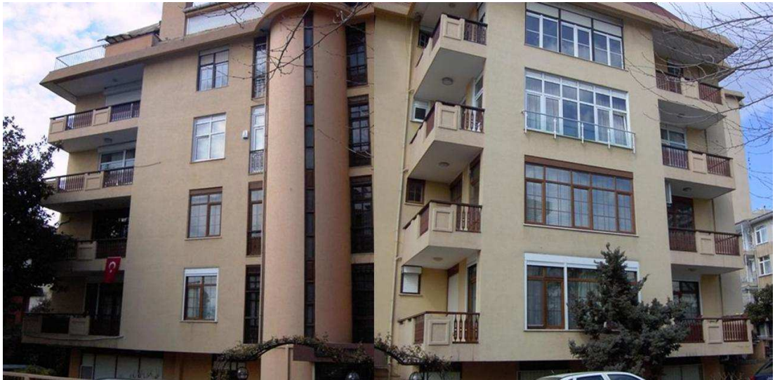
Şekil 4.1 : Bina'nın genel görünüşü.
