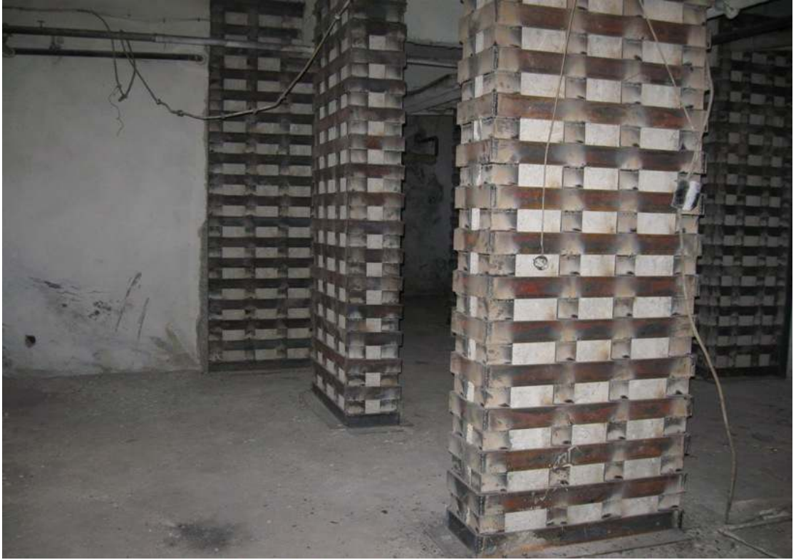
Şekil 3.17. Kolonların çelik ile sarılması
