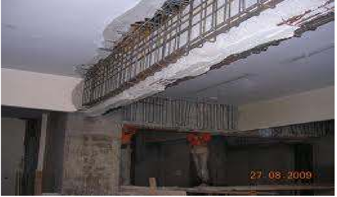
Şekil 3.21. Dıştan etriye ekleme
