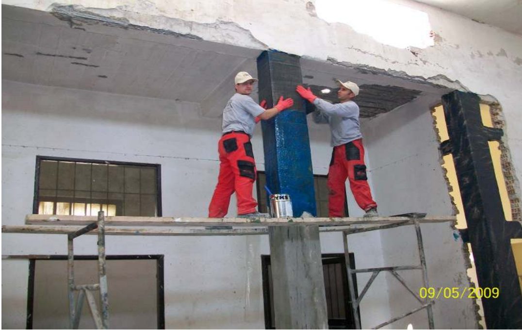
Şekil 3.18. Kolonların lifli polimer ile sarılması
