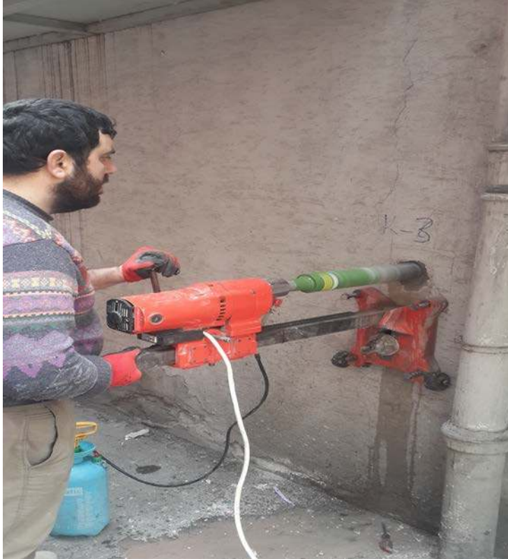
Şekil 3.14. Betonarme kolondan karot alınması
