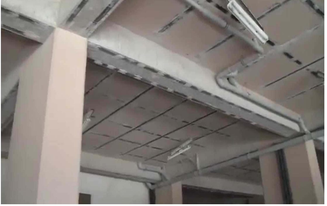
Şekil 3.28. Döşemelerin çelik levhalarla güçlendirilmesi
