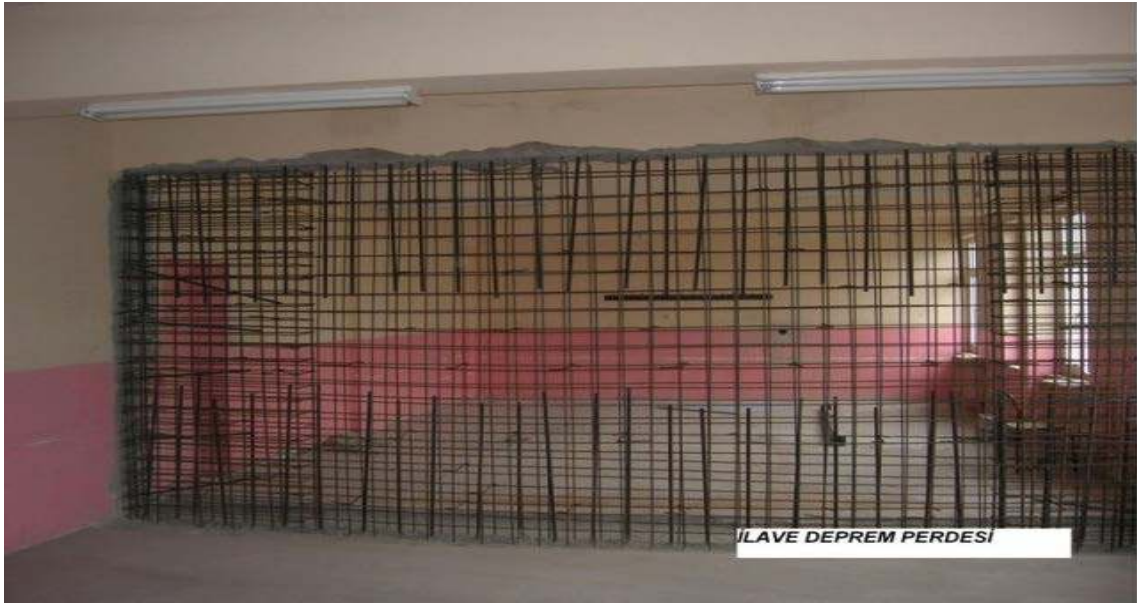
Şekil 3.25. Betonarme perde eklenmesi
