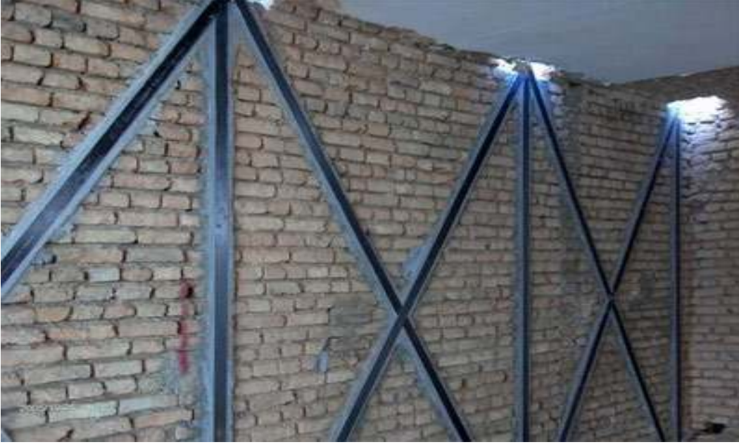
Şekil 3.24. Dolgu duvarların güçlendirilmesi
