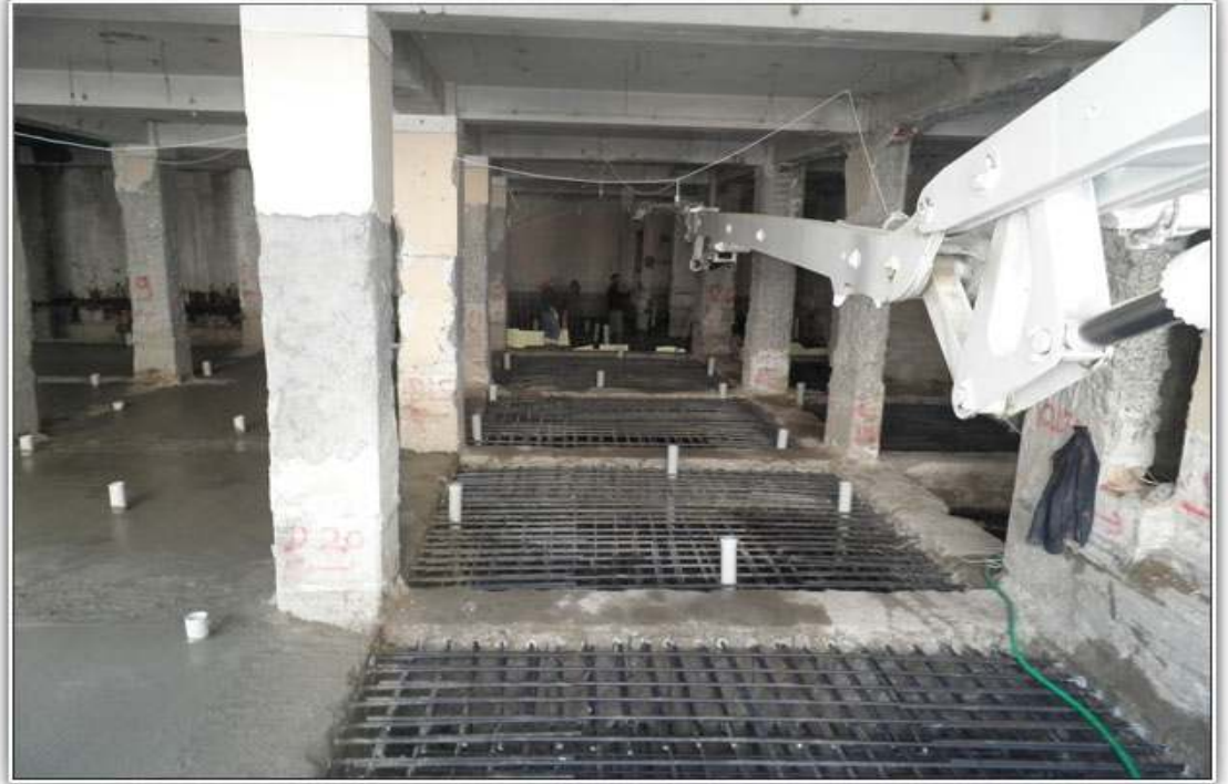
Şekil 3.29. Döşemelerin yeniden yapılarak güçlendirilmesi
