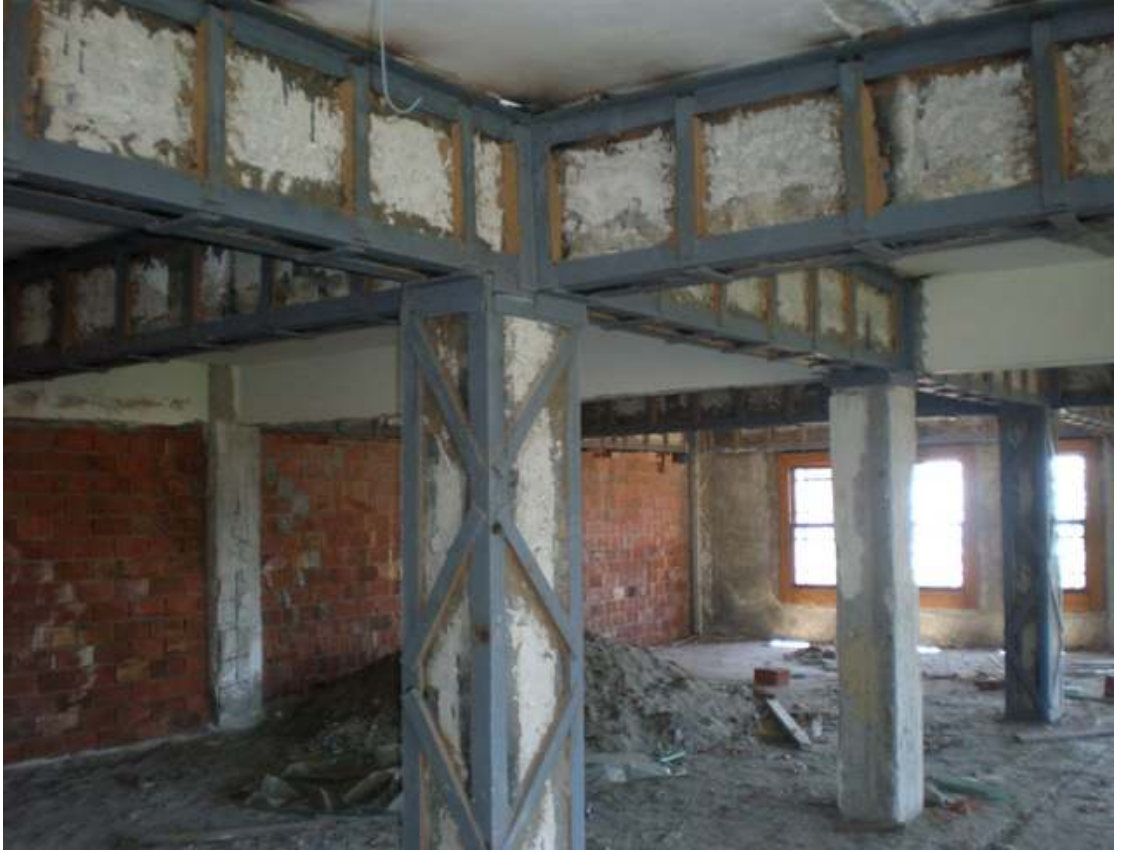
Şekil 3.23. Kirişlerin çelik ile sarılması
