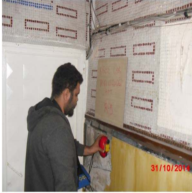
Şekil 3.11. Yüzey taraması yapılması ( Ferroskan cihazı yardımıyla)
