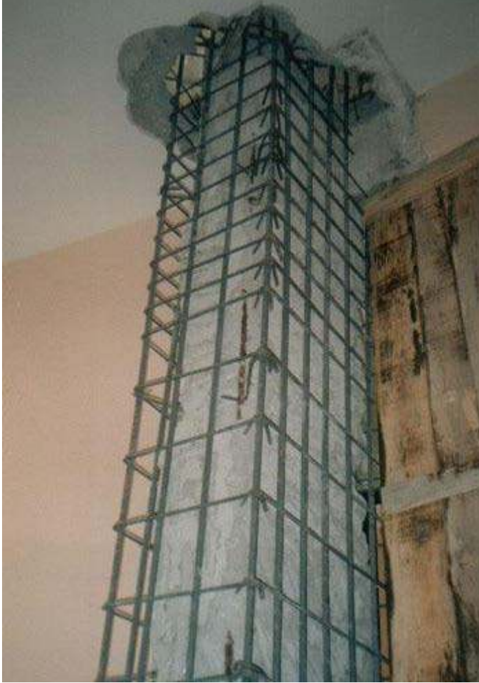
Şekil 3.19. Kolonların kesitlerinin büyütülmesi
