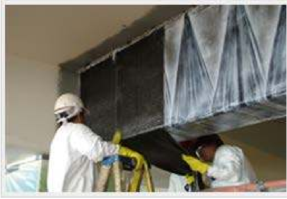
Şekil 3.22. Kirişlerin lifli polimer ile sarılması
