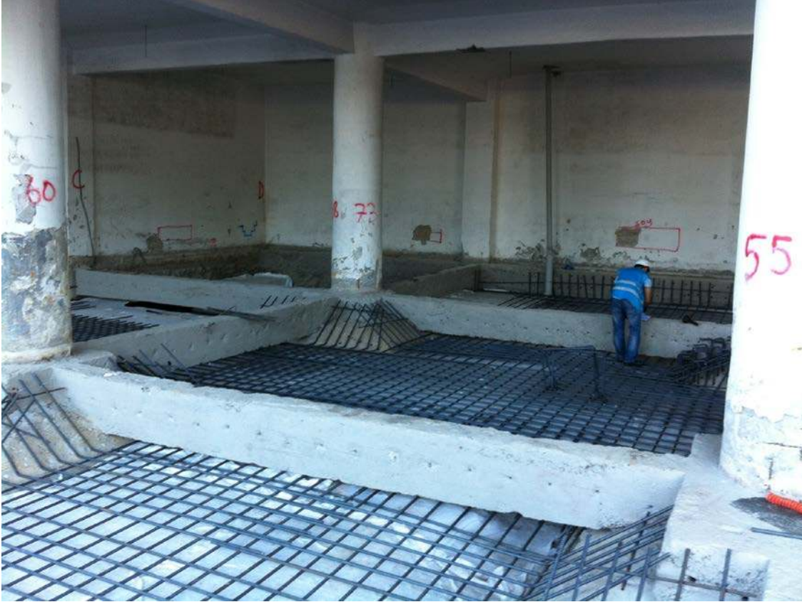
Şekil 3.27. Temellerin güçlendirilmesi
