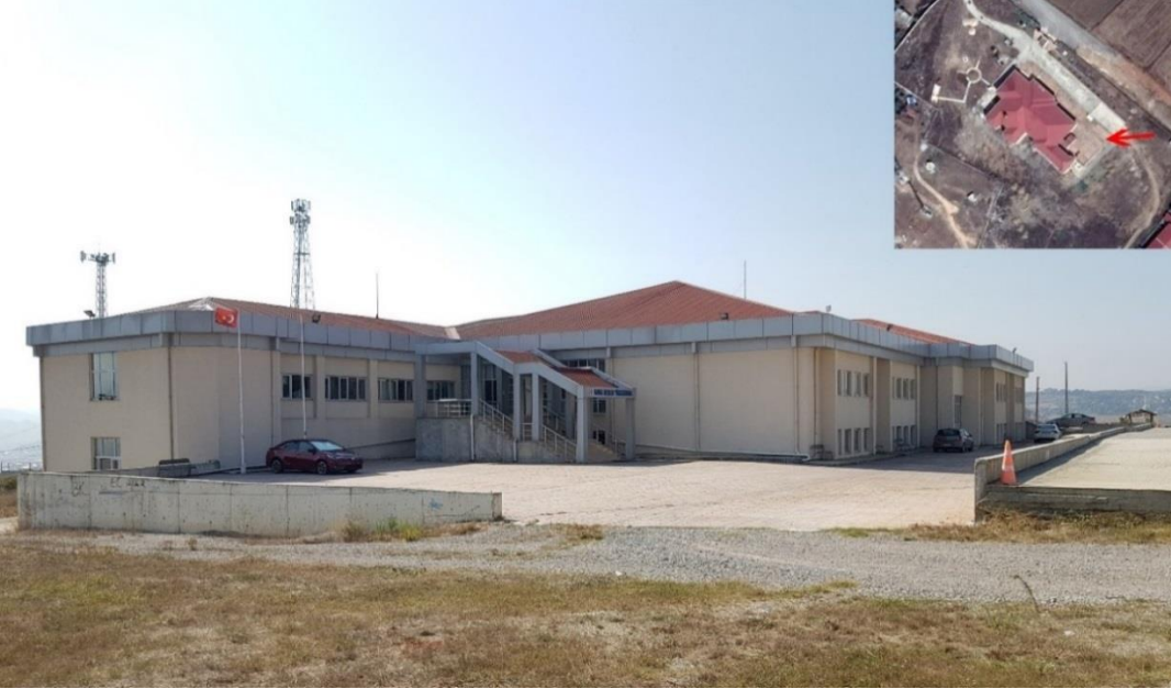
Şekil 4.8. İncelenen yapının doğu yönü ana girişi
