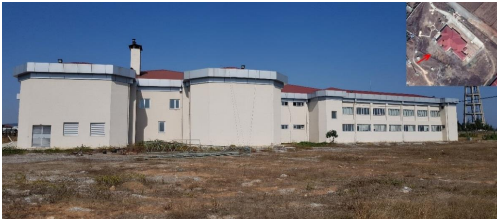
Şekil 4.6. İncelenen yapının güneybatı cephesi
