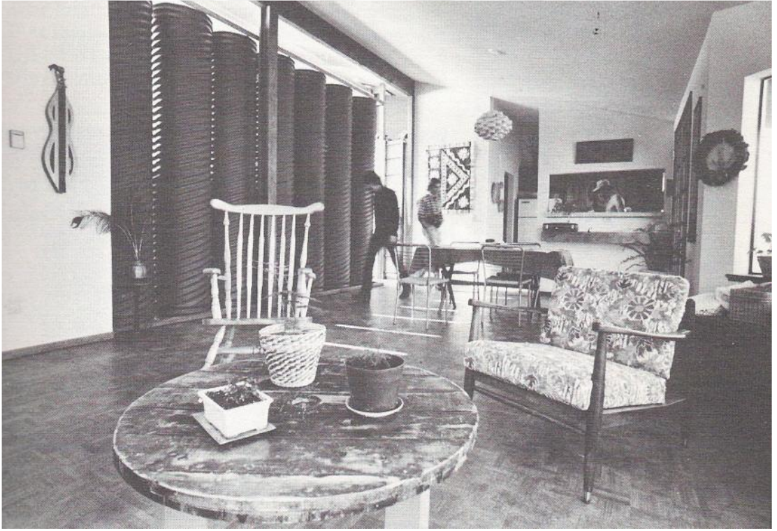
Şekil 3.13. Su duvarı uygulanmış örneği (Mazria, 1979)
