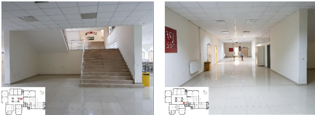
Şekil 4.11. İncelenen yapının bodrum kata inen merdiveni ve hol (bodrum kat)
