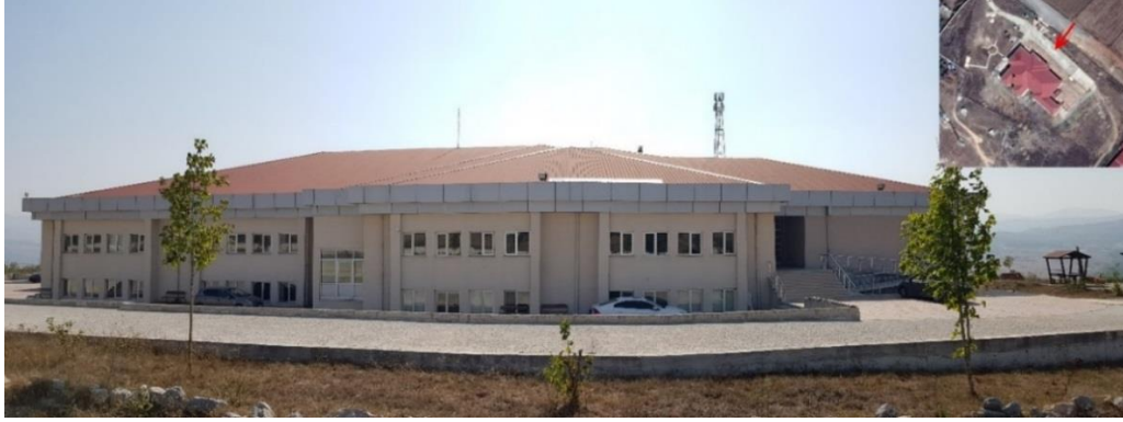
Şekil 4.4. İncelenen yapının kuzey doğu cephesi
