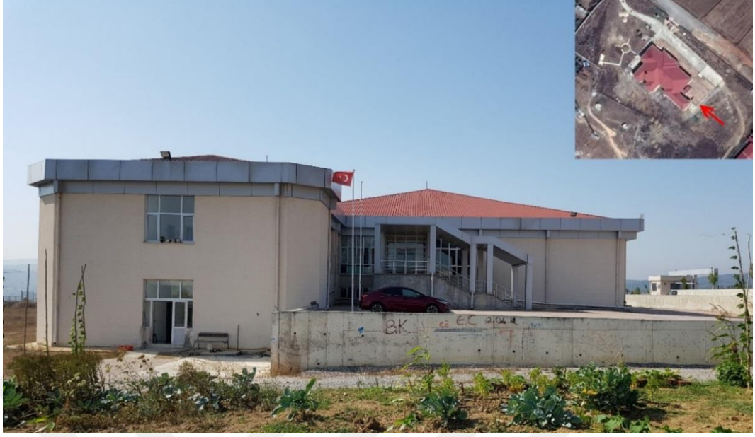
Şekil 4.7. İncelenen yapının güneydoğu cephesi
