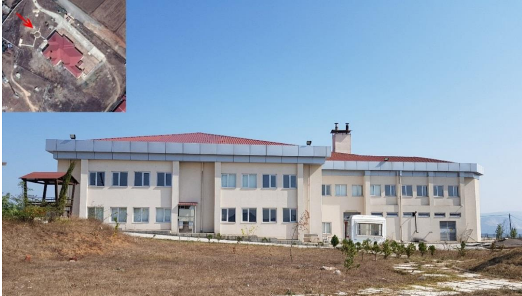
Şekil 4.5. İncelenen yapının kuzeybatı cephesi
