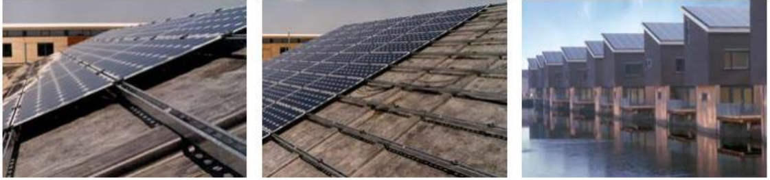
Şekil 3.16. Çatı örtüsüne monte edilmiş PV uygulaması örneği (Özkılıç Keleş, 2008)
