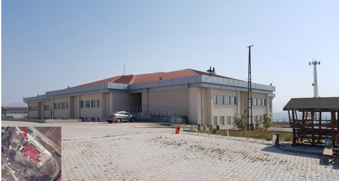
Şekil 4.3. İncelenen yapı kuzey yönü öğrenci girişi
