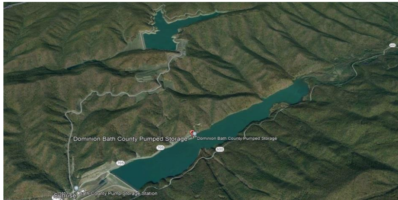
Şekil 5.4. Bath County Pompaj Depolama İstasyonu
