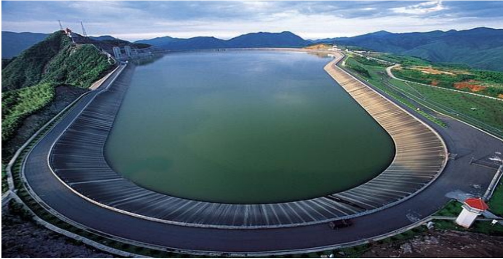
Şekil 5.2. Guangdong Pompaj Depolama Tesisi
