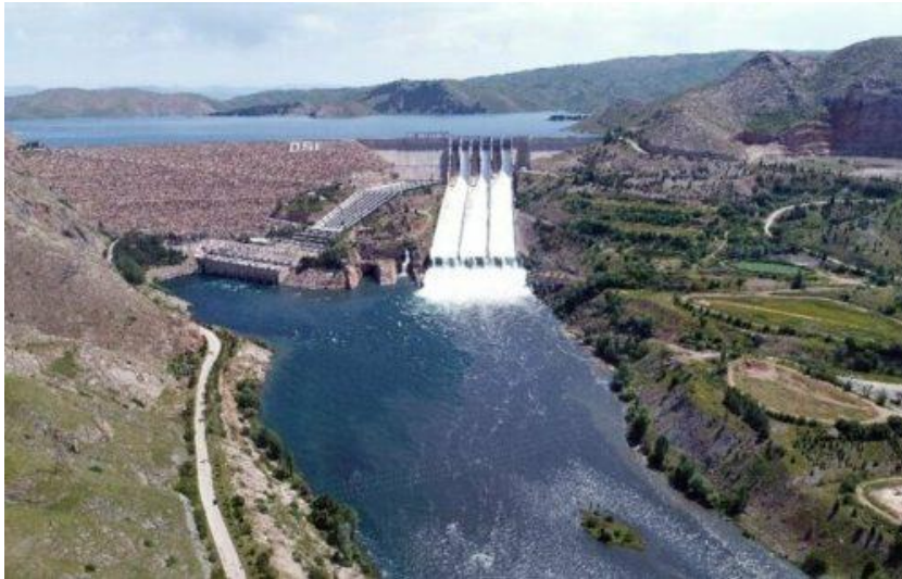
Şekil 3.10. Keban Barajı ve HES
