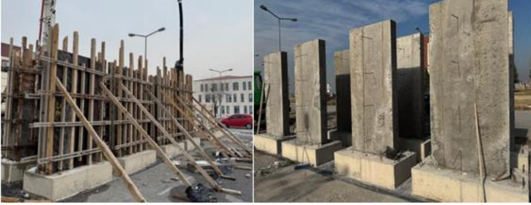
Şekil 15. Perde beton dökümülmesi ve kalıp söküldükten sonraki görüntüsü
