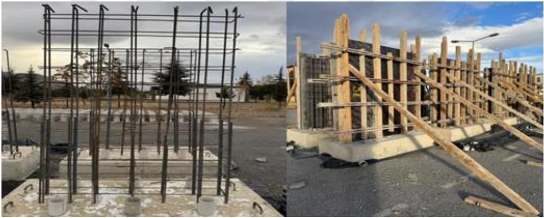
Şekil 14. Perde kalıp ve demir imalatı
