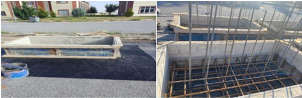
Şekil 12. Temel kalıp ve Demir imalatı
