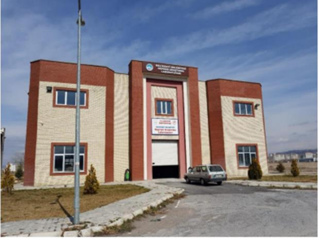
Şekil 10. Erciyes Üniversitesi Deprem Araştırmaları Laboratuvarı
