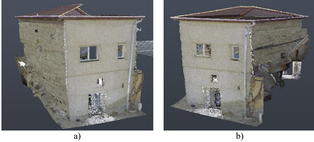
Şekil 3.13. Mevcut Örnek Yığma Yapıya Ait 3D Lazer Tarama Uygulamaları (Autodesk, ReCap 2026).
