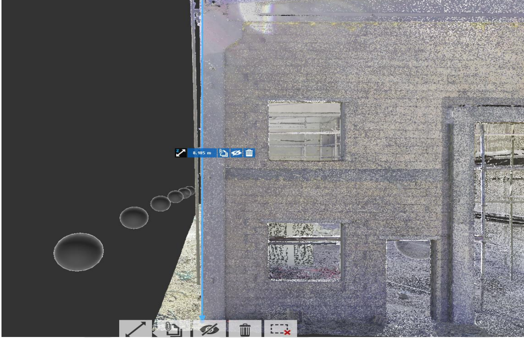
Şekil 4.10. Mevcut Örnek Prefabrik Yapının Kolonunun Düşeydeki Aks Kontrolü (Autodesk, ReCap 2026).
