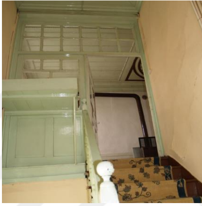
Şekil 4.59 Mahmut Dede Sk. No:25'te bulunan yapının zemin katından üst kata çıkan ahşap merdiveni
