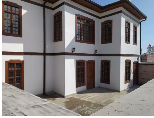
Şekil 4.83 Aslanlı Kışla Cd. No:15'te bulunan yapının günümüzde restore edilmiş hali (2022)
