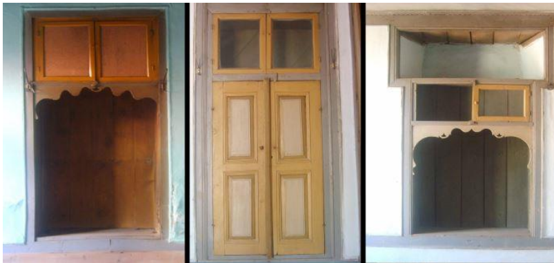
Şekil 4.43 Sokullu Mehmet Paşa Sk. No:14'te bulunan yapının iç mekânlarda bulunan ağzıaçık örnekleri (Konya Büyükşehir Belediyesi, 2010)
