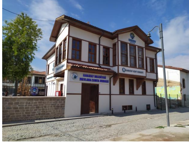
Şekil 4.14 Celal Sk. No:26'da bulunan yapının Celal sokağa bakan güncel hali (2022)
