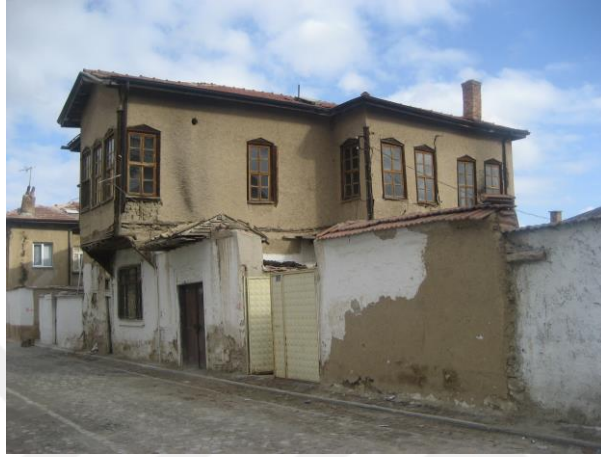
Şekil 4.63 Mahmut Dede Sk. No:21'de yer alan yapının restore edilmeden önce yola bakan cephesi (Ramazan Demir rölöve raporu, 2008)
