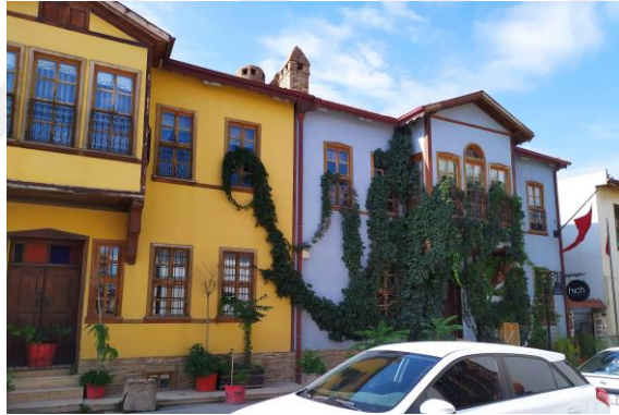
Şekil 4.35 Celal sk. No:6 ve No:8'de yer alan yapıların restorasyon sonrası kuzey cephesinden görünümü (2022)
