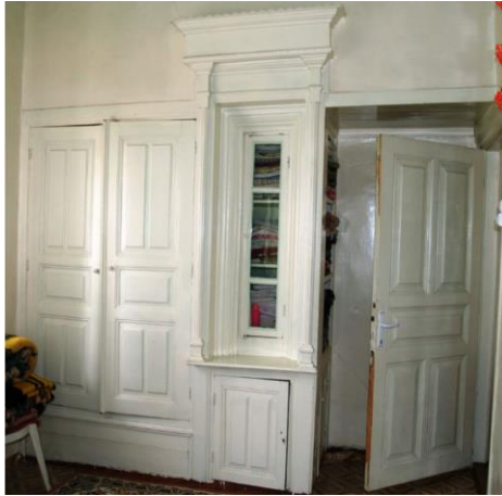
Şekil 4.60 Mahmut Dede Sk. No:25'te bulunan yapının odalarda bulunan gömme dolap ve aynalık detayı
