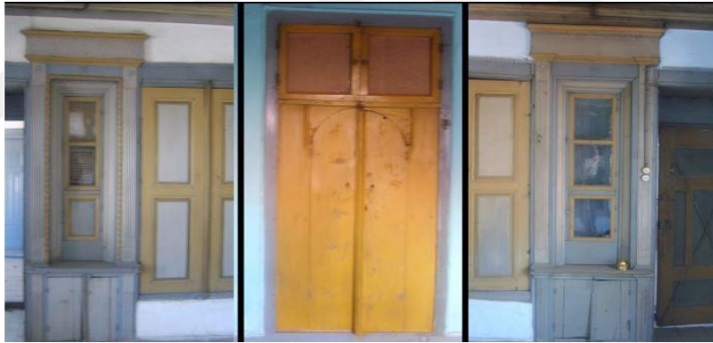
Şekil 4.42 Sokullu Mehmet Paşa Sk. No:14'te bulunan yapının iç mekânlarda bulunan çiçeklik örnekleri (Konya Büyükşehir Belediyesi, 2010)
