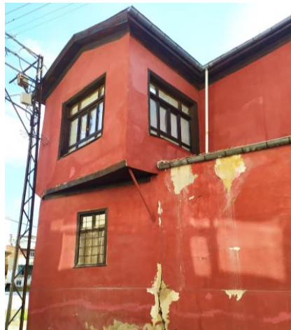
Şekil 4.4 Fakih sk. No:26'da bulunan yapının güncel hali, Fakih sokağı bakan batı cephesi (2022)
