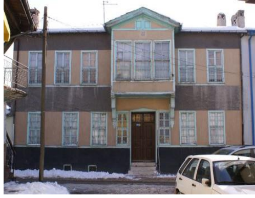
Şekil 4.17 Celal Sk. No:8 de bulunan yapının restorasyon öncesine ait görseli, Kuzey cephesi (Konya Büyükşehir Belediyesi, 2010)
