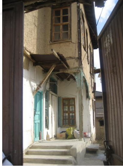
Şekil 4.64 Mahmut Dede Sk. No:21'de yer alan yapıya girişi sağlayan, basamaklarla çıkılan taşlık mekânı (Ramazan Demir rölöve raporu, 2008)
