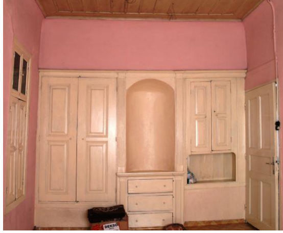
Şekil 4.29 Celal Sk. No:6 da bulunan yapının birinci katındaki odada bulunan ahşap yüklük ve çiçeklik (Kudeb arşiv, 2022)
