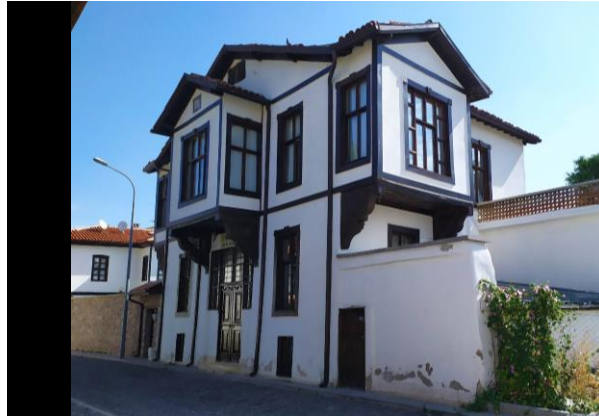
Şekil 4.57 Mahmut Dede Sk. No:25'te bulunan yapının restore edildikten sonra günümüzde ki cephe görseli (2022)
