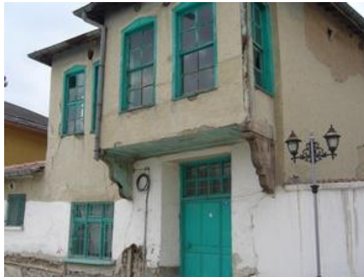
Şekil 4.75 Mahmut Dede Sk. No:20'de bulunan yapının restore edilmeden önceki hali (kent bilgi sistemi)
