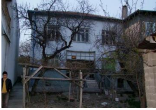
Şekil 4.34 Restore edilmeden önce 4 numaralı (Celal sk. No:6) yapının arka bahçe avlusuna bakan güney cephesinden görünümü (Kudeb arşiv, 2019)
