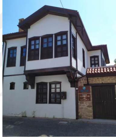
Şekil 4.70 Mahmut Dede Sk. No:21’de yer alan yapının mevcut durumu, yola bakan cephesi
