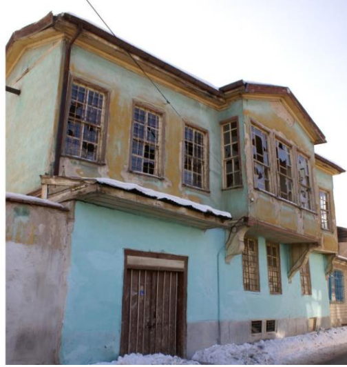
Şekil 4.9 Celal Sk. No:26'da bulunan yapının restore edilmeden önceki hali (Konya Büyükşehir Belediyesi, 2010)
