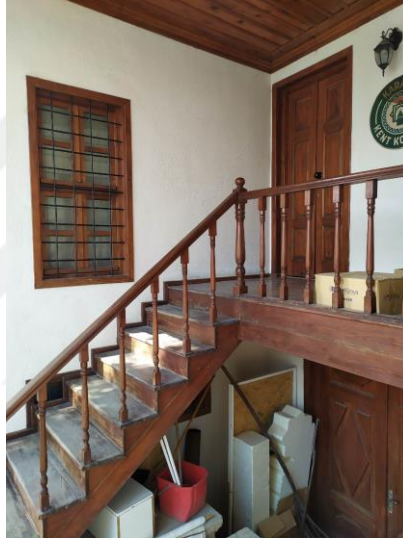
Şekil 4.15 Celal Sk. No:26'da bulunan yapının kuzey cephesinden verilen giriş kapısı (2022)
