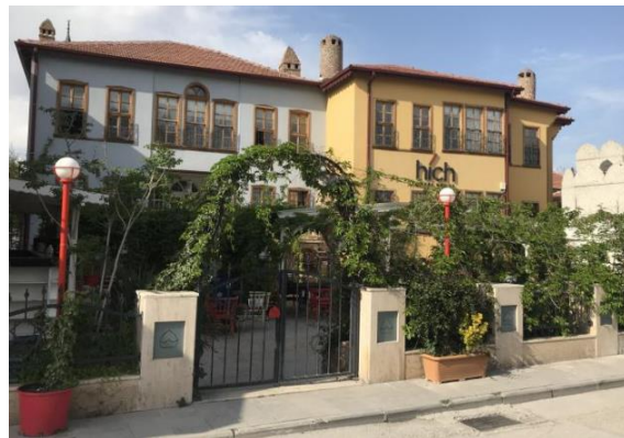
Şekil 4.36 Celal sk. No:6 ve No:8'de yer alan yapıların restorasyon sonrası güney cephesinden görünümü (2022)
