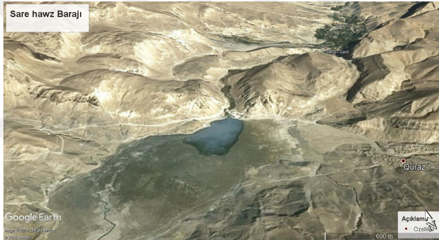
Şekil 3.4. Sare Hawz barajı uydu görünümü
