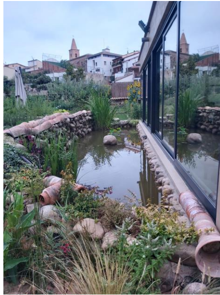
Fotoğraf 6.9. Yağmur suyu hasat havuzu.
