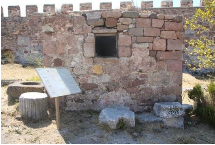
Şekil 4.81. Su haznesindeki dolap açıklığı
