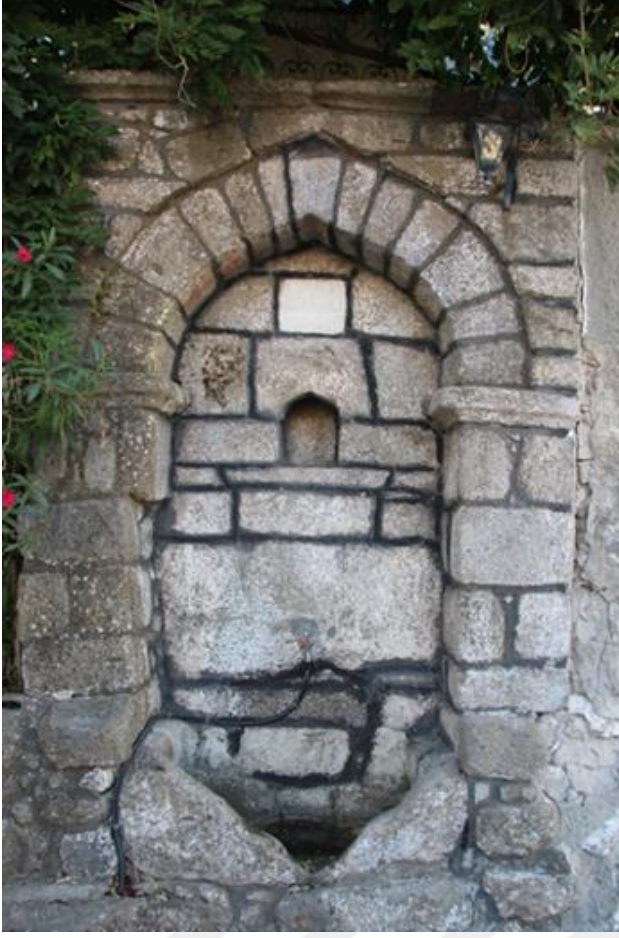
Şekil 4.54. Hacı Osman Çeşmesi ön cephe
