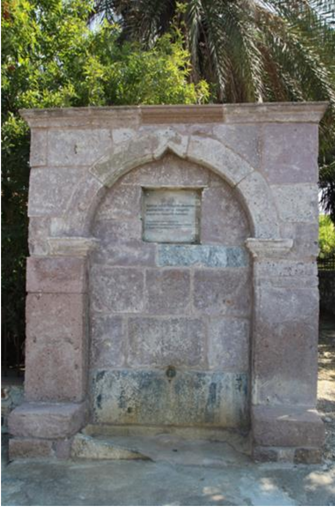
Şekil 4.154. Sarı Ilıca Çeşmesi ön cephe
