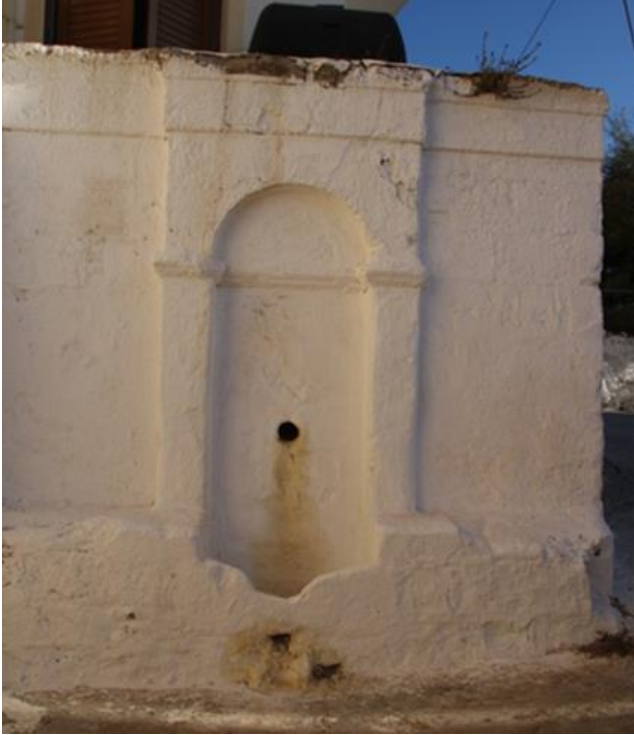
Şekil 4.159. Sıgri Kasabası Çeşme 1 ön cephe
