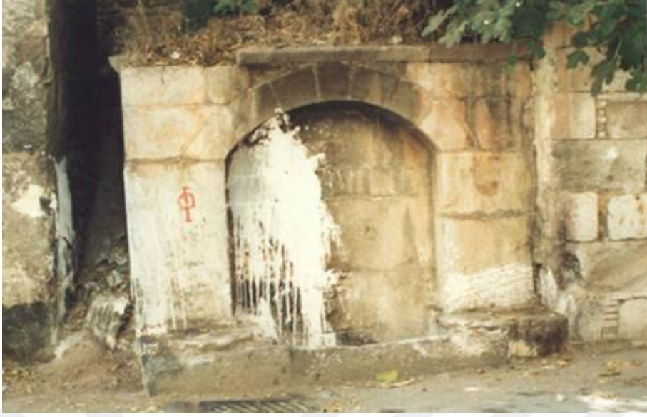
Şekil 4.65. Yapının eski görünümü 140
