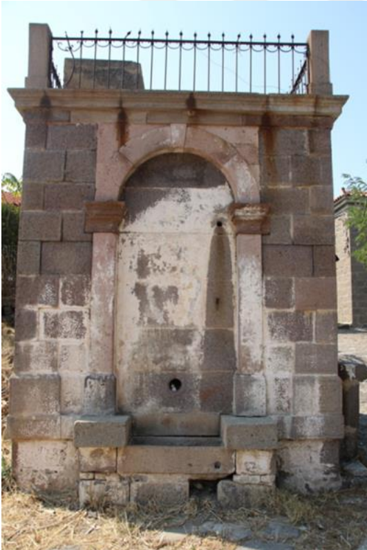
Şekil 4.59. Yapının kitablesiz cephesi
