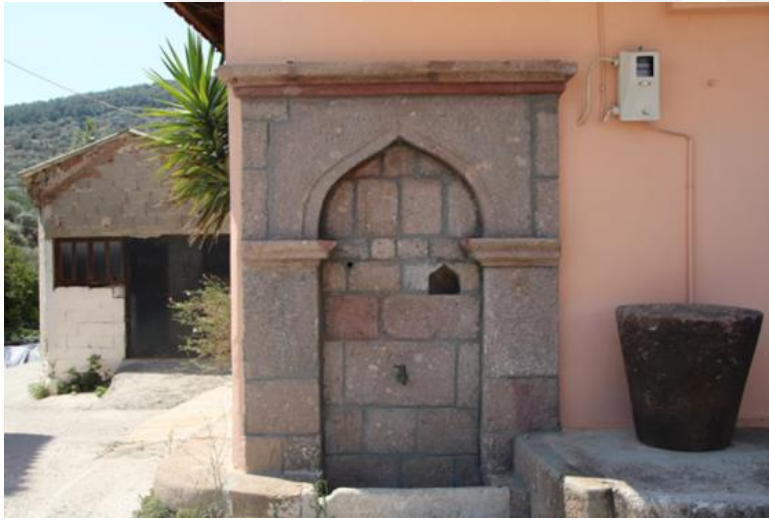
Şekil 4.67. Komi Köyü Çeşme 1 ön cephe
