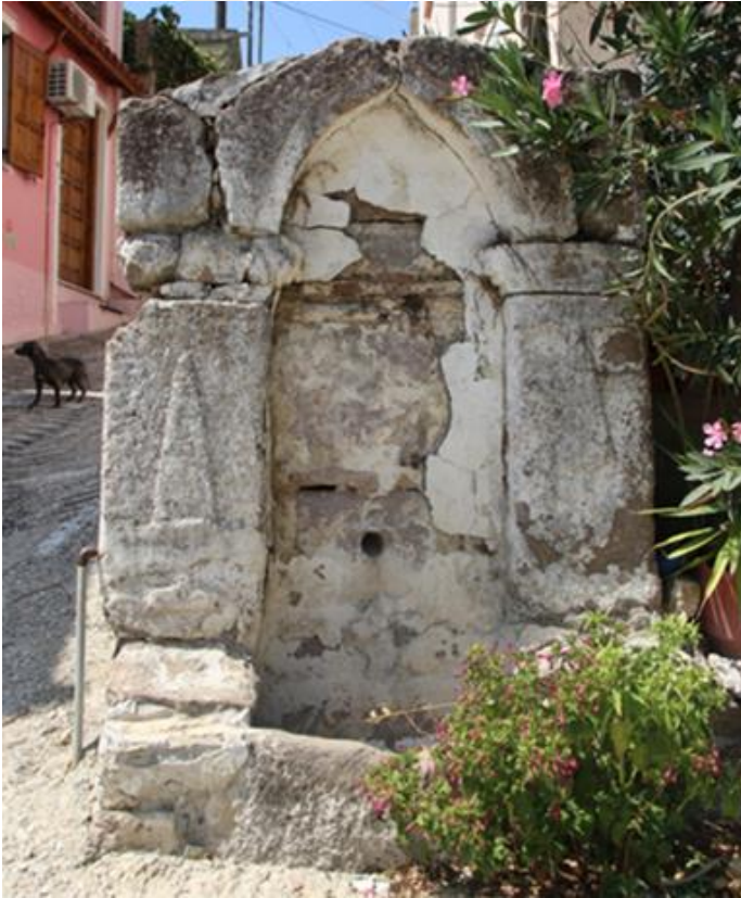
Şekil 4.71. Komi Köyü Çeşme 2 ön cephe
