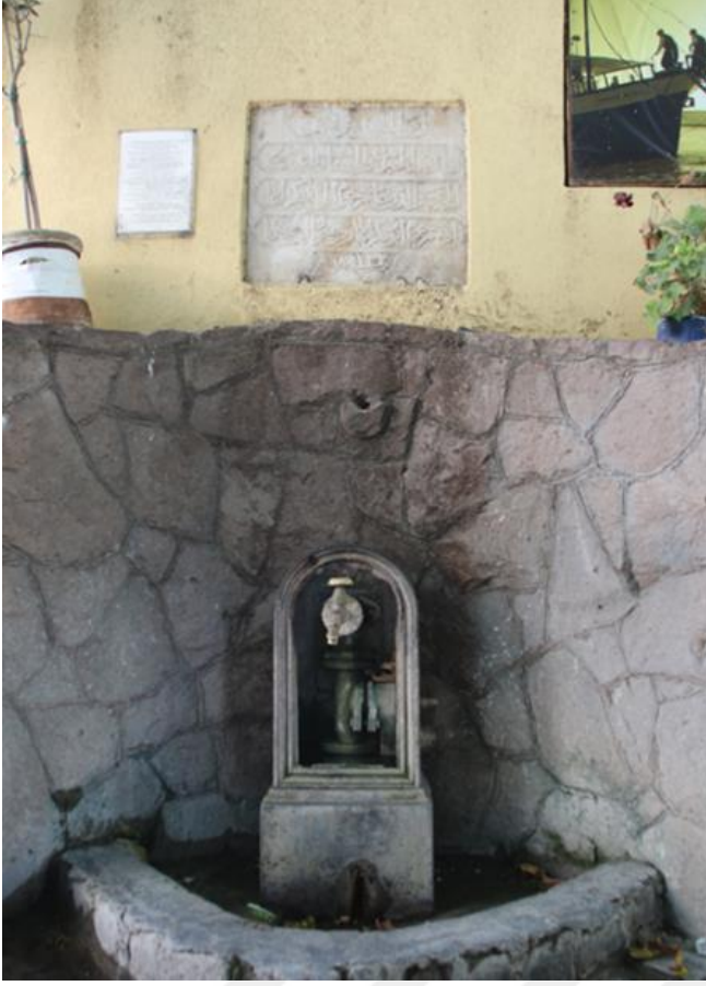
Şekil 4.145. Pilmar Çeşmesi ön cephe
