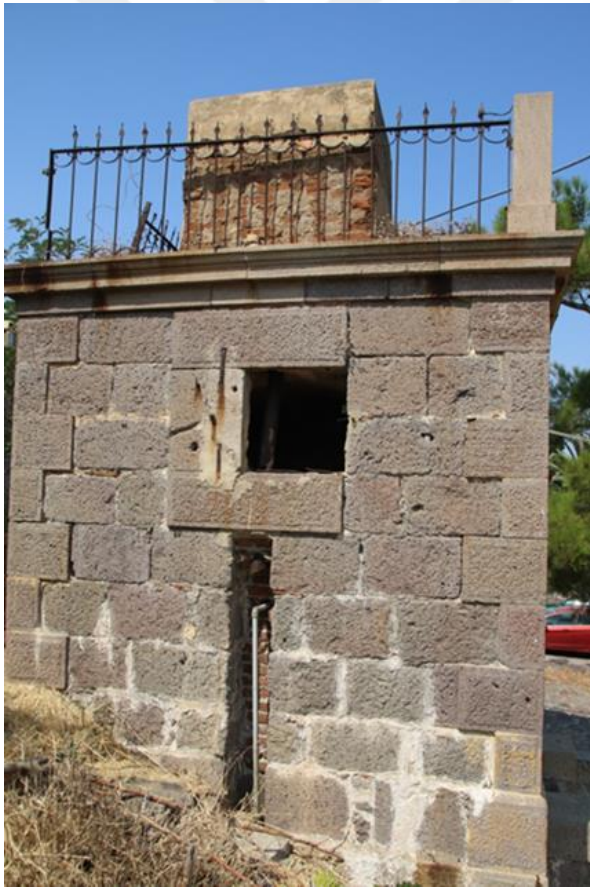
Şekil 4.61. Su haznesi- Dolap açıklığı
