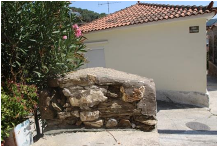
Şekil 4.73. Yapının arka cephe görünümü
