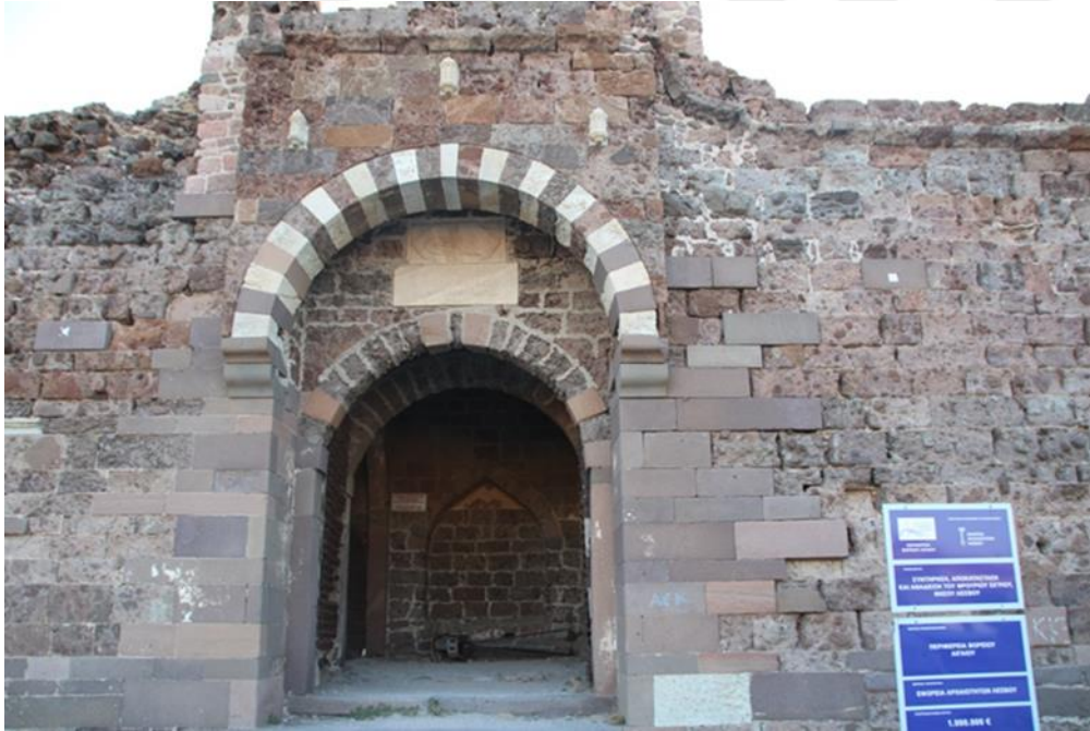
Şekil 2.4. Sigri Kalesi giriş kapısındaki III. Osman tuğrası ve kitabe
