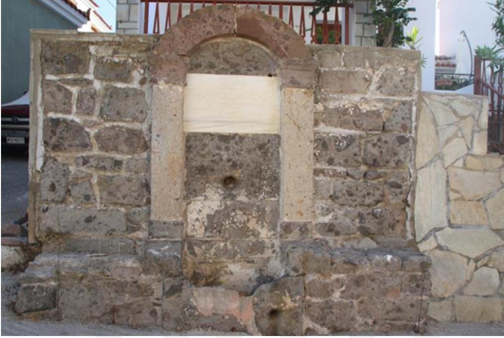
Şekil 4.150. Safvet Hanım Çeşmesi ön cephe
