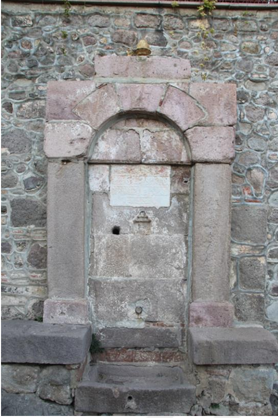
Şekil 4.40. Hacı Ahmet Ağa Çeşmesi ön cephe
