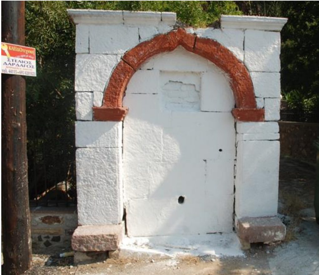
Şekil 4.157. Çeşmenin restorasyon geçirmeden önceki durumu (M. Zeki İbrahimgil)
