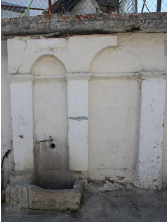
Şekil 4.166. Skalochoori Köyü Çeşme 2 ön cephe
