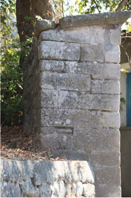
Şekil 4.164. Yapının yan cephesi
