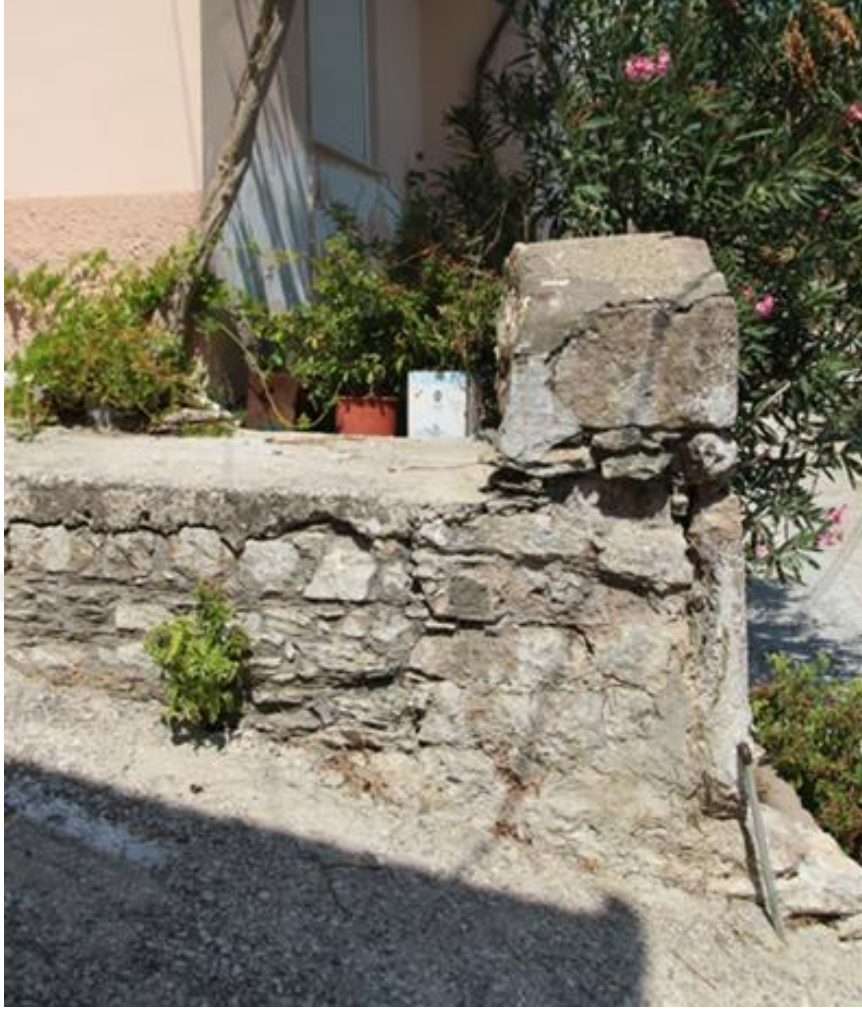
Şekil 4.72. Yapının yan cepheden görünümü
