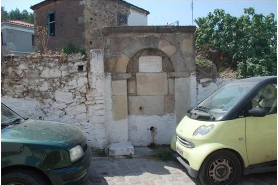
Şekil 4.27. Fahri Paşa Çeşmesi ön cephe (M. Zeki İbrahimgil)
