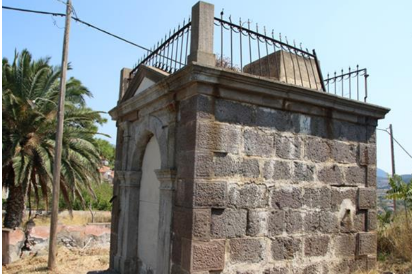
Şekil 4.60.Yapının yan cepheden görünümü
