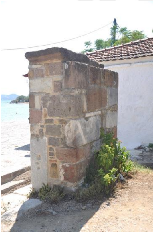
Şekil 4.184. Yapının arka cephe görünümü
