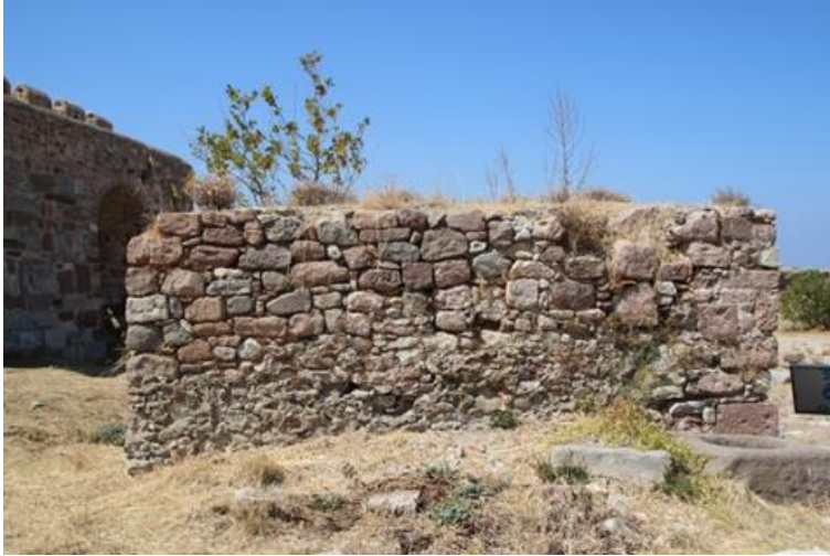
Şekil 4.82. Kısmen toprak altındaki su haznesi
