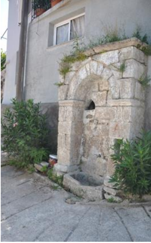
Şekil 4.171. Yapının genel görünümü (M. Zeki İbrahimgil)
