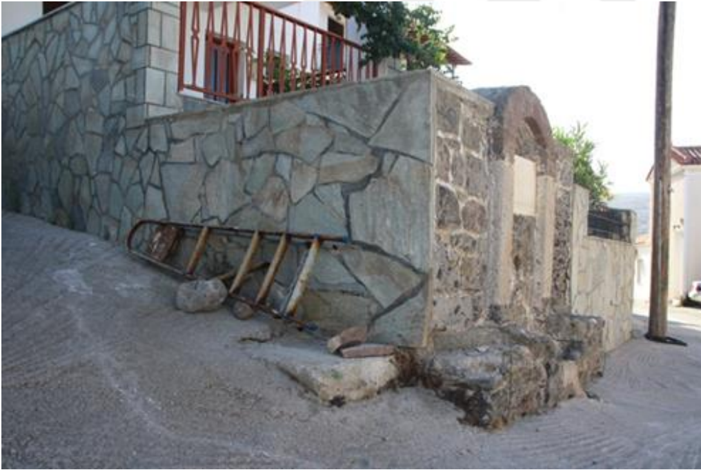
Şekil 4.151. Yapının yan cepheden görünümü
