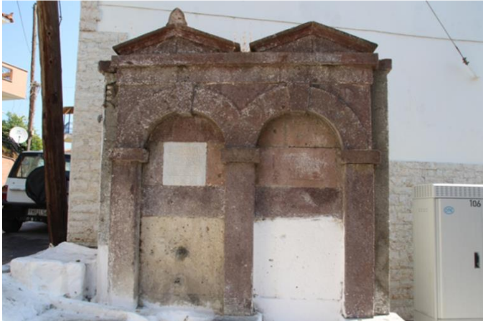
Şekil 4.14. Ayşe Hatun Çeşmesi ön cephe
