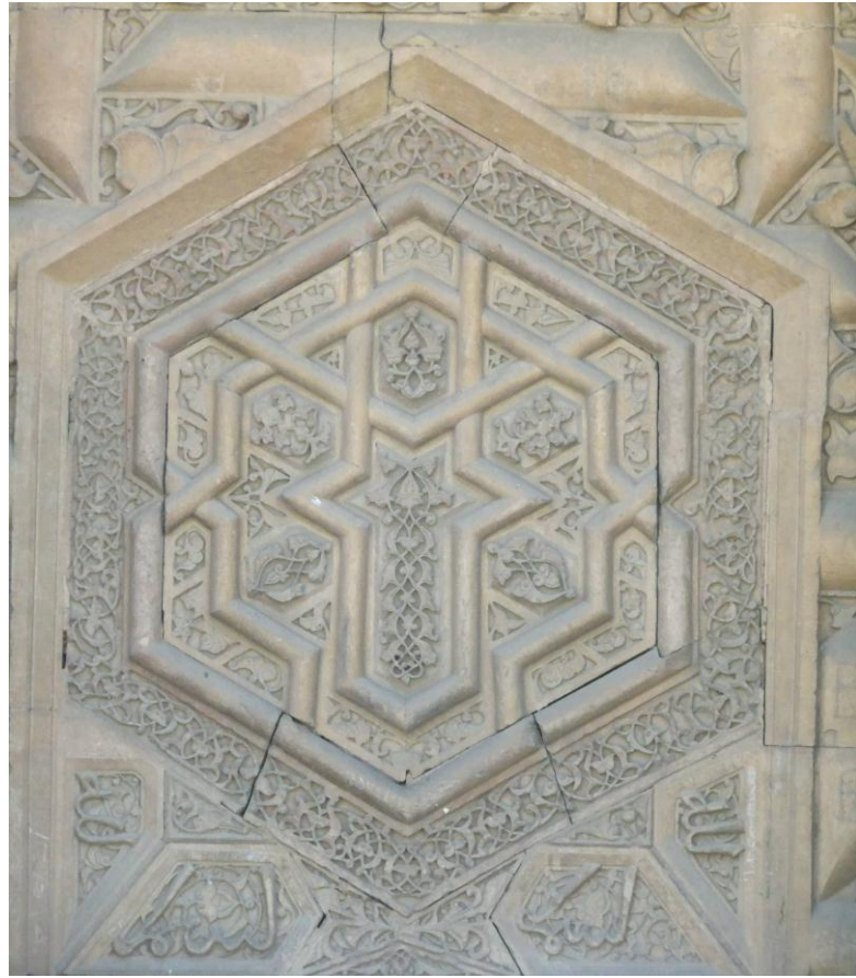
Şekil-100 Kapı Başlığı (Düğümlü geçmelerden oluşan 6 kollu yıldız motifi ile yapılan kompozisyon.) (Divriği Ulu Camii)
