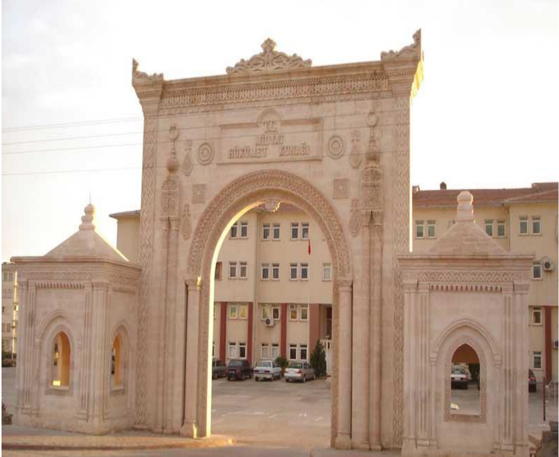
Şekil-22 Midyat Hükümet Konağı Giriş Kapısı
