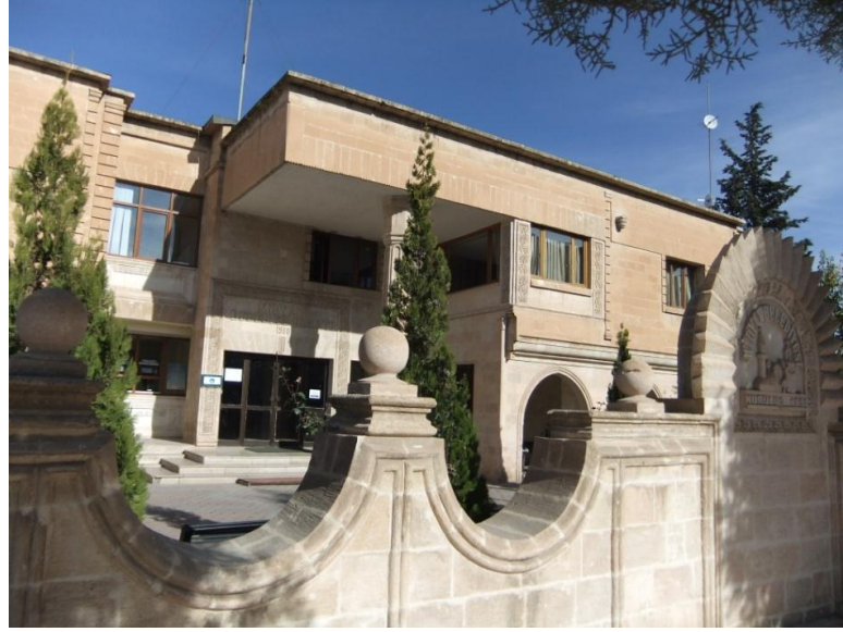
Şekil-17 Midyat Belediye Binası
