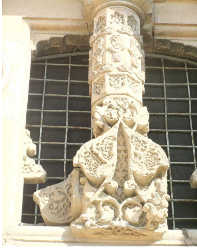
Şekil-119 Kolon (Şifahane kapısının üstünde duran ve caminin denge kolonu 1939 Erzincan depremine kadar dönüyormuş ama şuan sabit duruyor.) (Divriği Ulu Camii)
