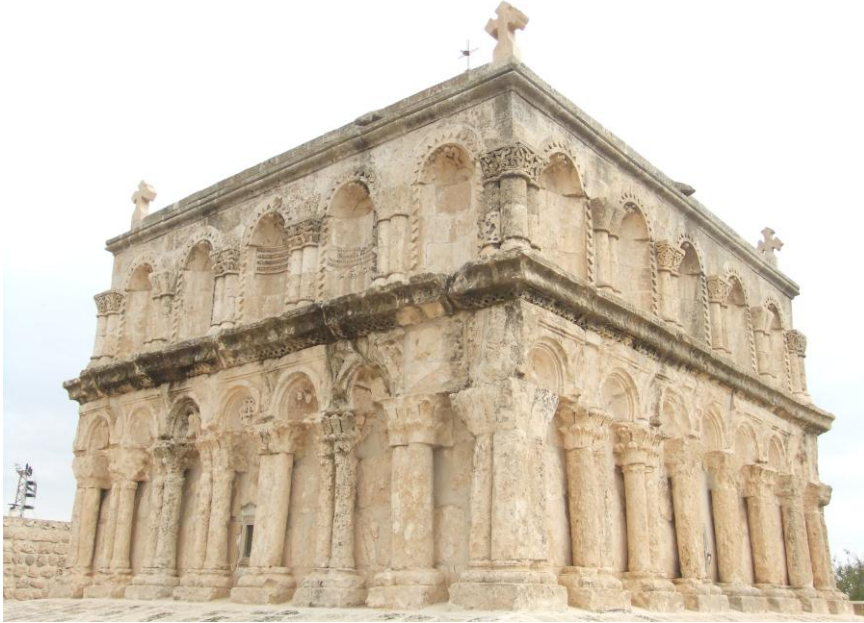
Şekil-75 Kilise (Güney cephesinin genel görünüşü.) (Meryem Ana Kilisesi)
