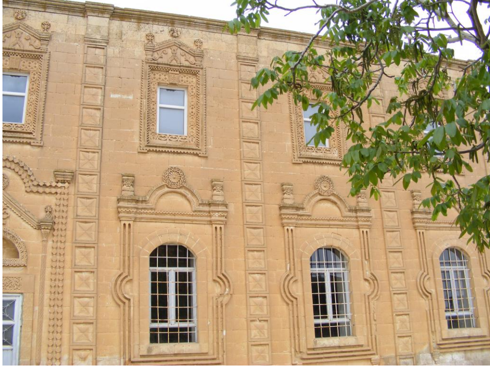
Şekil-72 Cephe süslemesi(Mor Şabrel Kilisesi)
