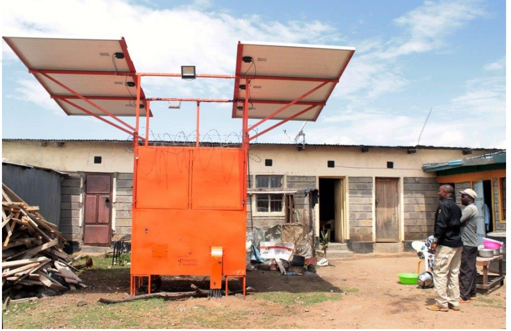
Şekil 1.3. PowerGen firmasının "PowerBox" birimi; 1.4 kW'lık güneş panelleri, 9kWh'lık piller ve 3kW'lık bir çevirici içeriyor.
