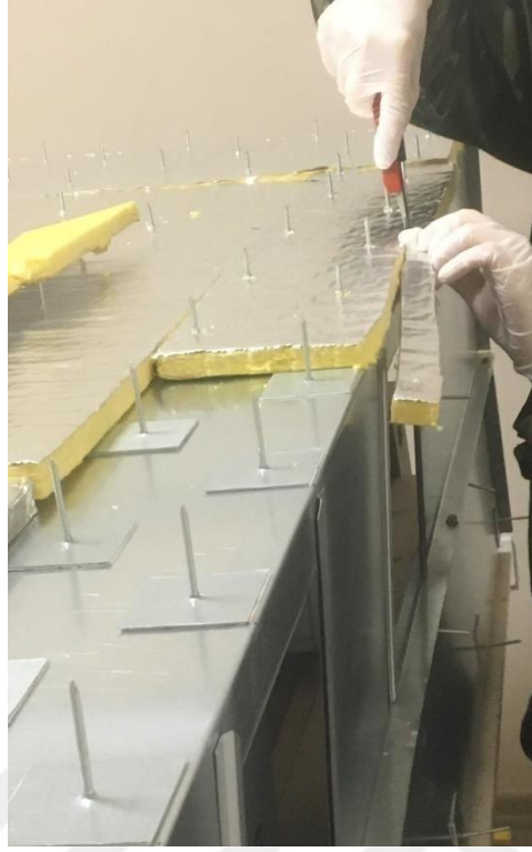
Şekil 3. 16. Alüminyum Kaplı Taş Yünü Yalıtım Levhası Uygulaması
