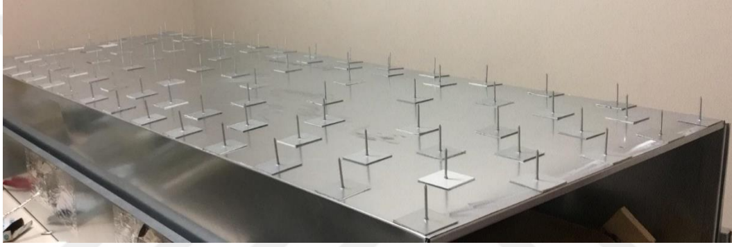
Şekil 3. 14. İzolasyon Piminin Sac Metal Üzerine Gelişigüzel Dağılımı
